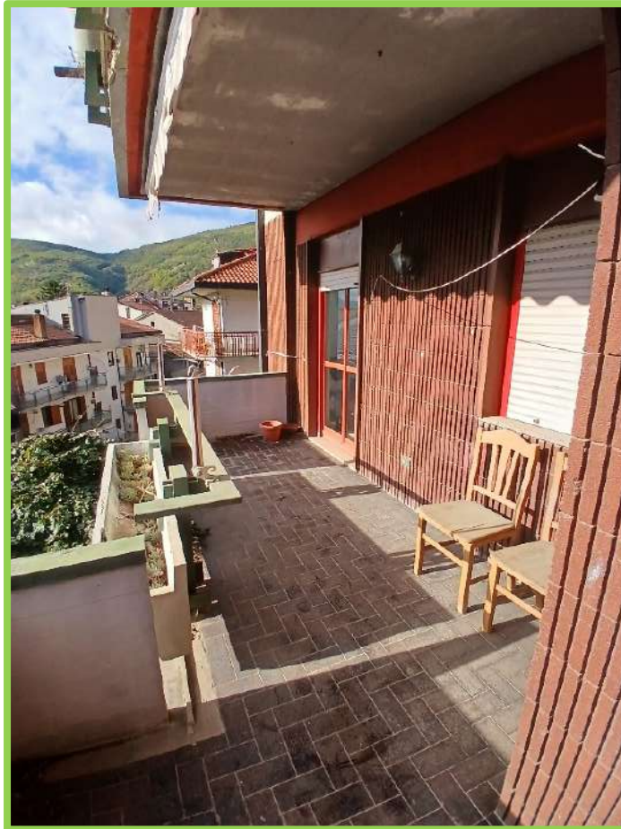
Foto n. 14 - Immobile oggetto di pignoramento - Balcone prospetto Sud-Est
