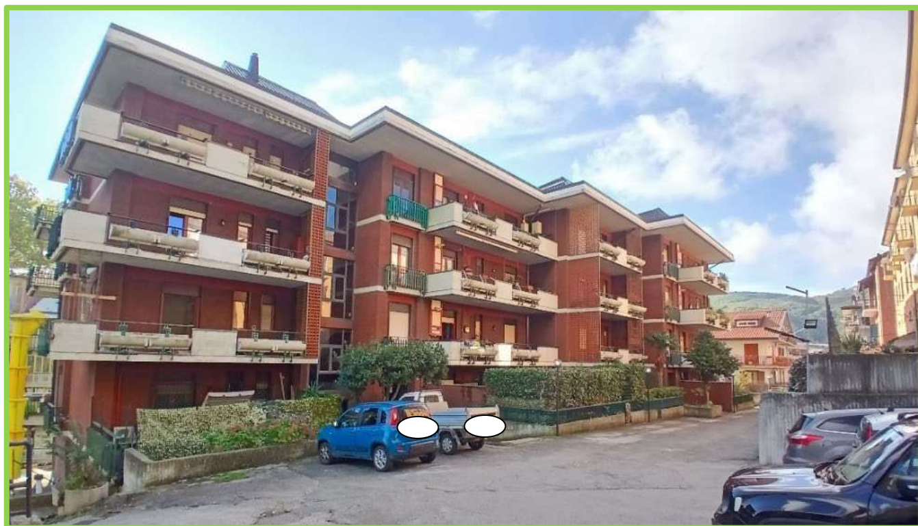
Foto n. 2 - Fabbricato condominiale di cui fa parte l'immobile oggetto di pignoramento
