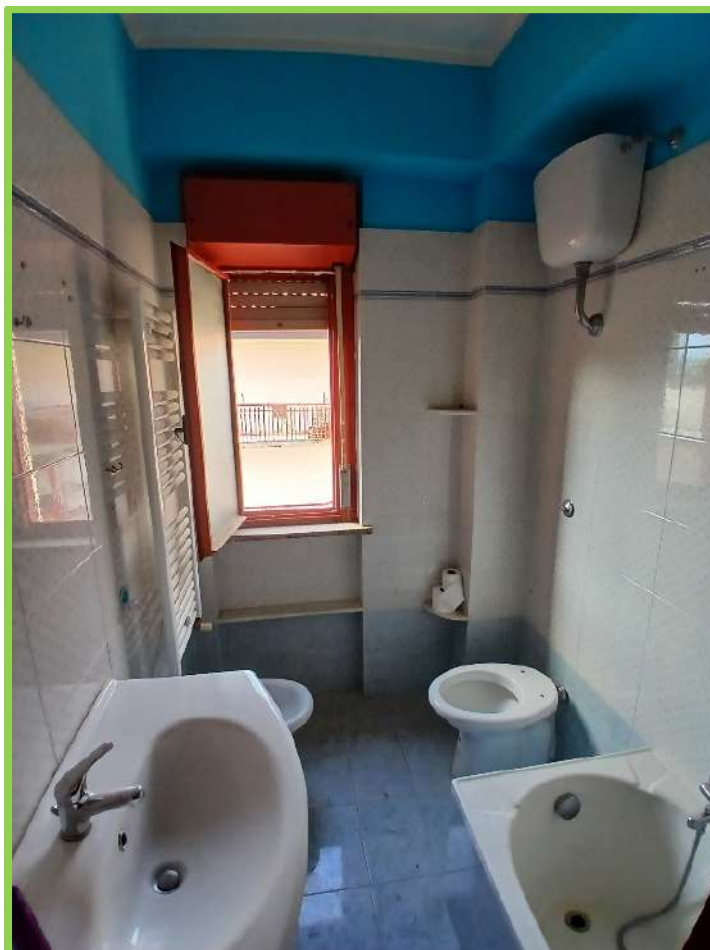
Foto n. 19 - Immobile oggetto di pignoramento – Bagno 2
