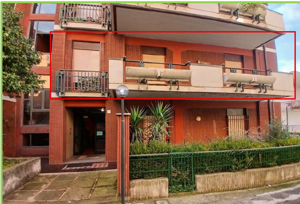
Foto n. 5 - Ingresso al fabbricato condominiale di cui fa parte l'immobile oggetto di pignoramento con individuazione dello stesso
