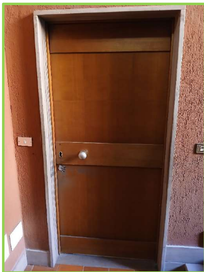
Foto n. 8 - Ingresso immobile oggetto di pignoramento – piano primo – vista da vano scala – Scala A
