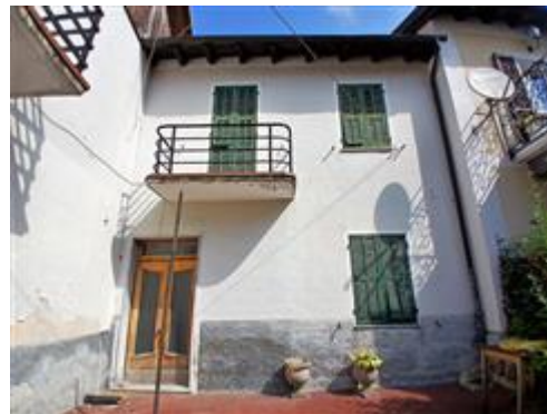
FABBRICATO VIA AL CASTELLO 12
