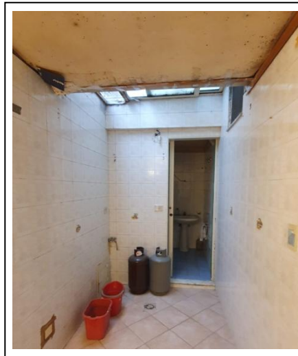
Foto n. 9 accesso al wcb
