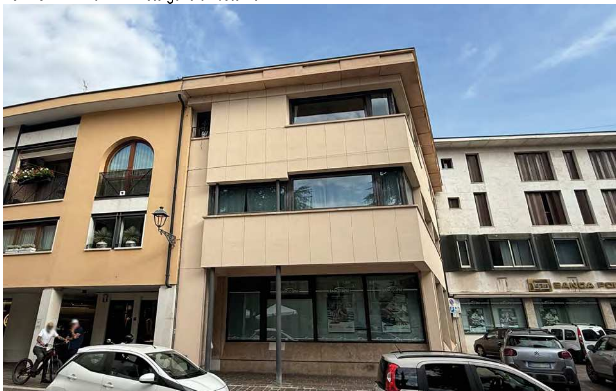
Foto A – Vista esterna da Corso Mazzini
