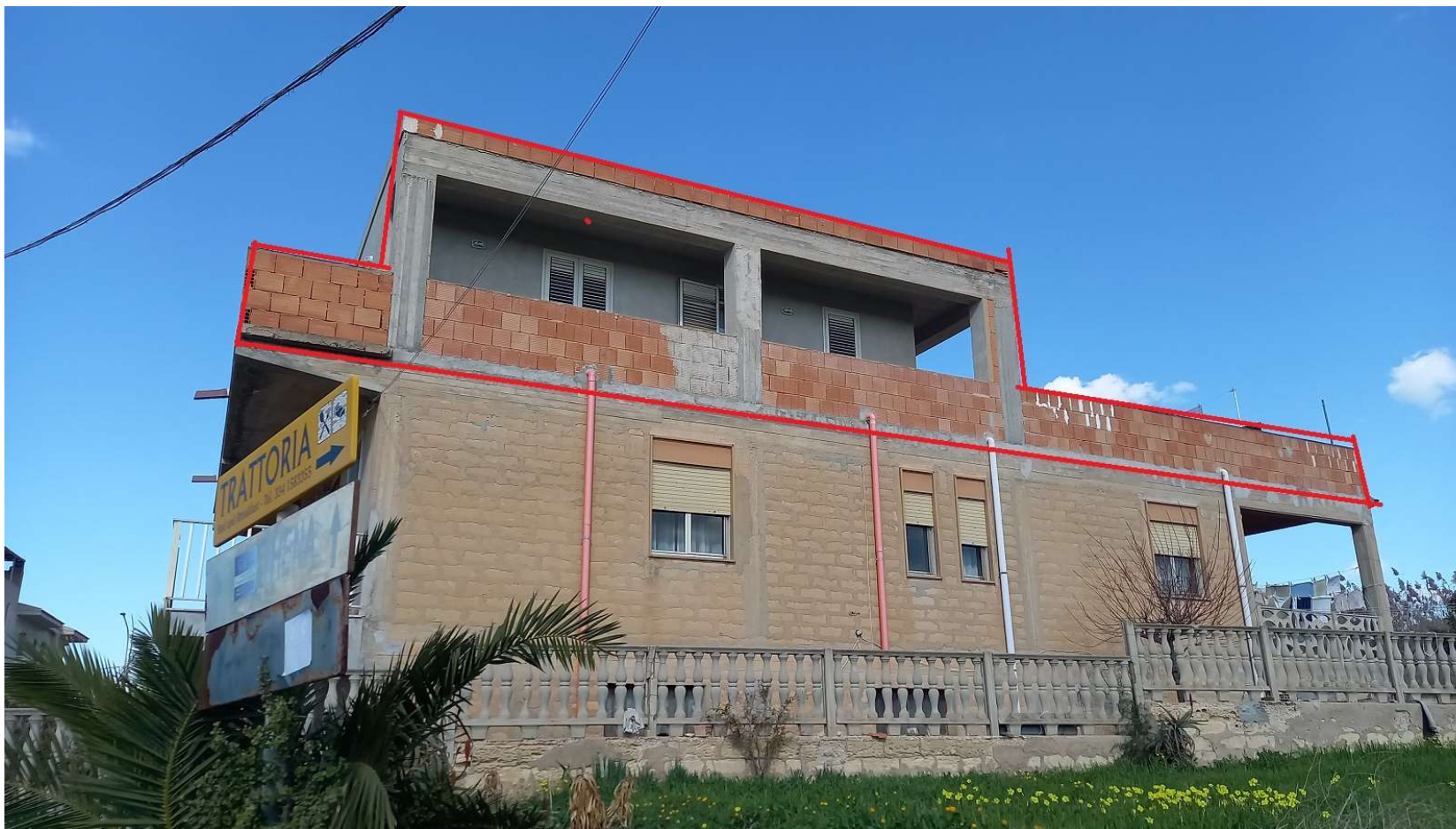
FOTO N. 2 - prospetto sud con indicazione immobile
