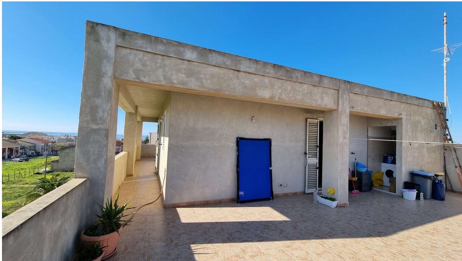
FOTO N. 4 -prospetto est su terrazza
