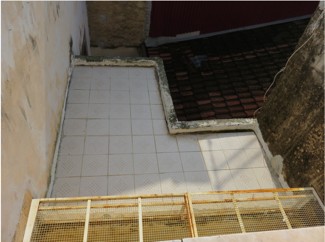
Foto 48 - Vista dal terrazzo 2° piano, Particolare
