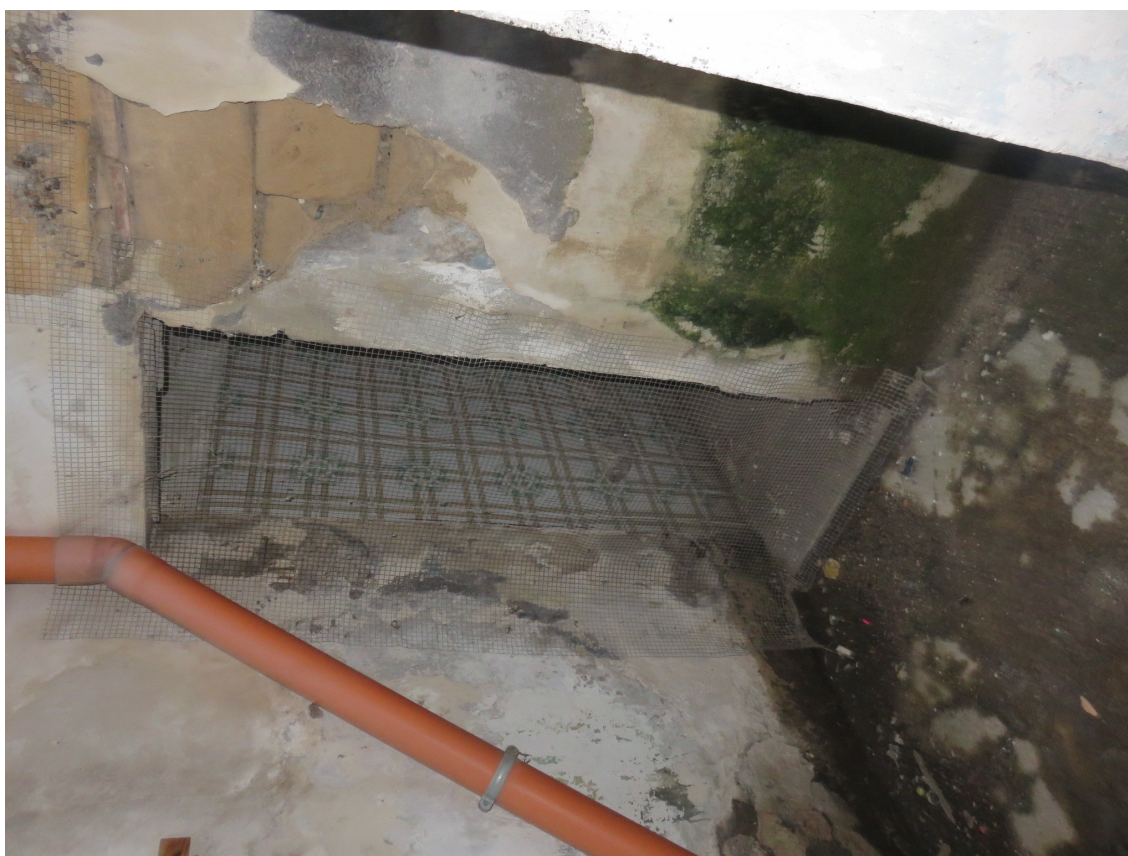
Foto 10 - Laboratorio Artigianale a p.t. Particolare cortiletto interno
