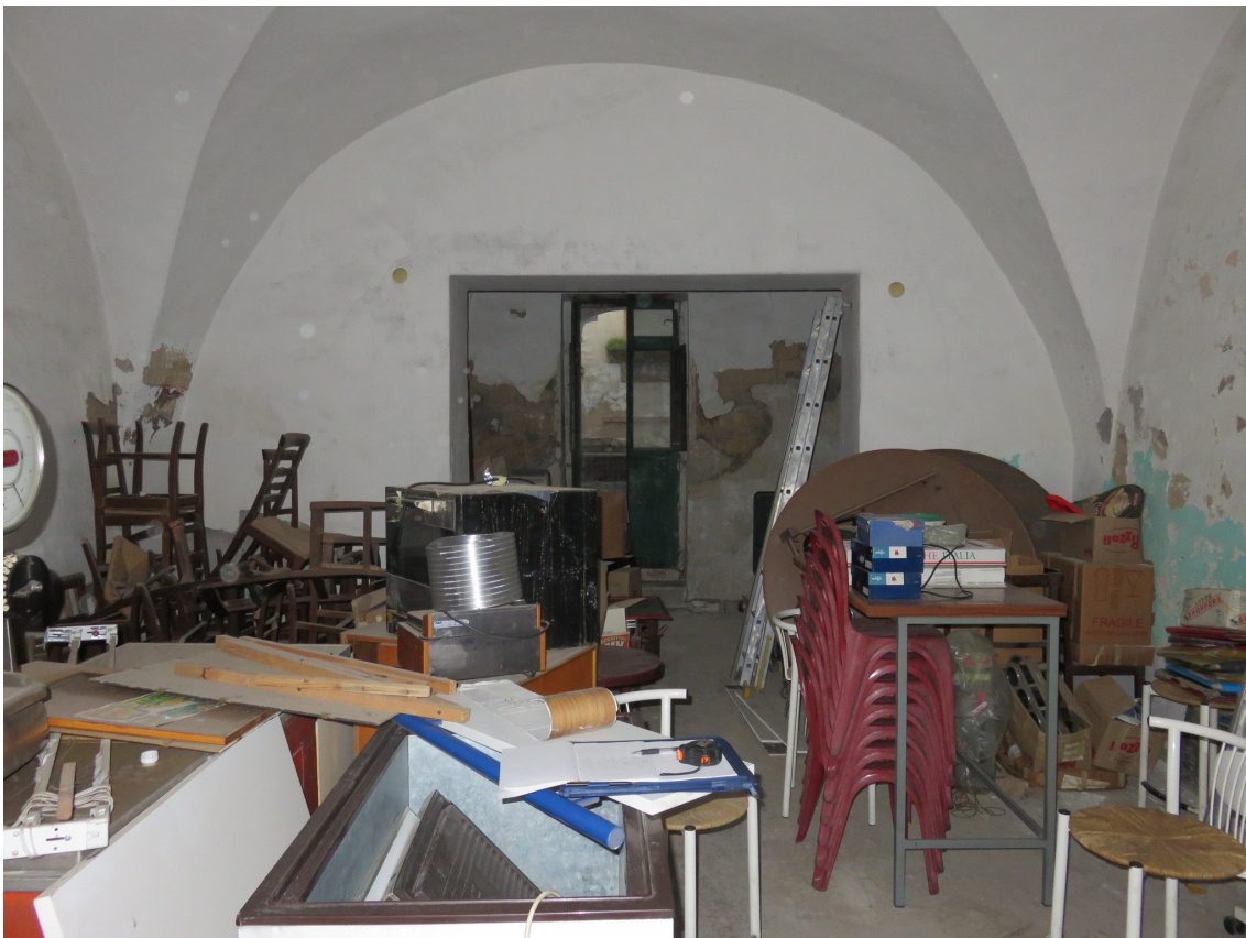
Foto 7 - Laboratorio Artigianale a piano terra
