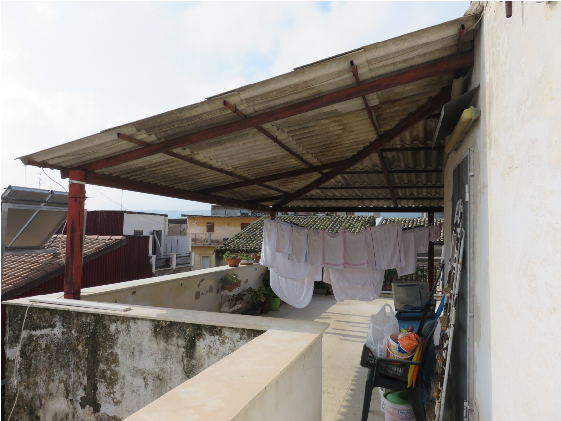
Foto 37 - Terrazzo e tettoia 2° piano
