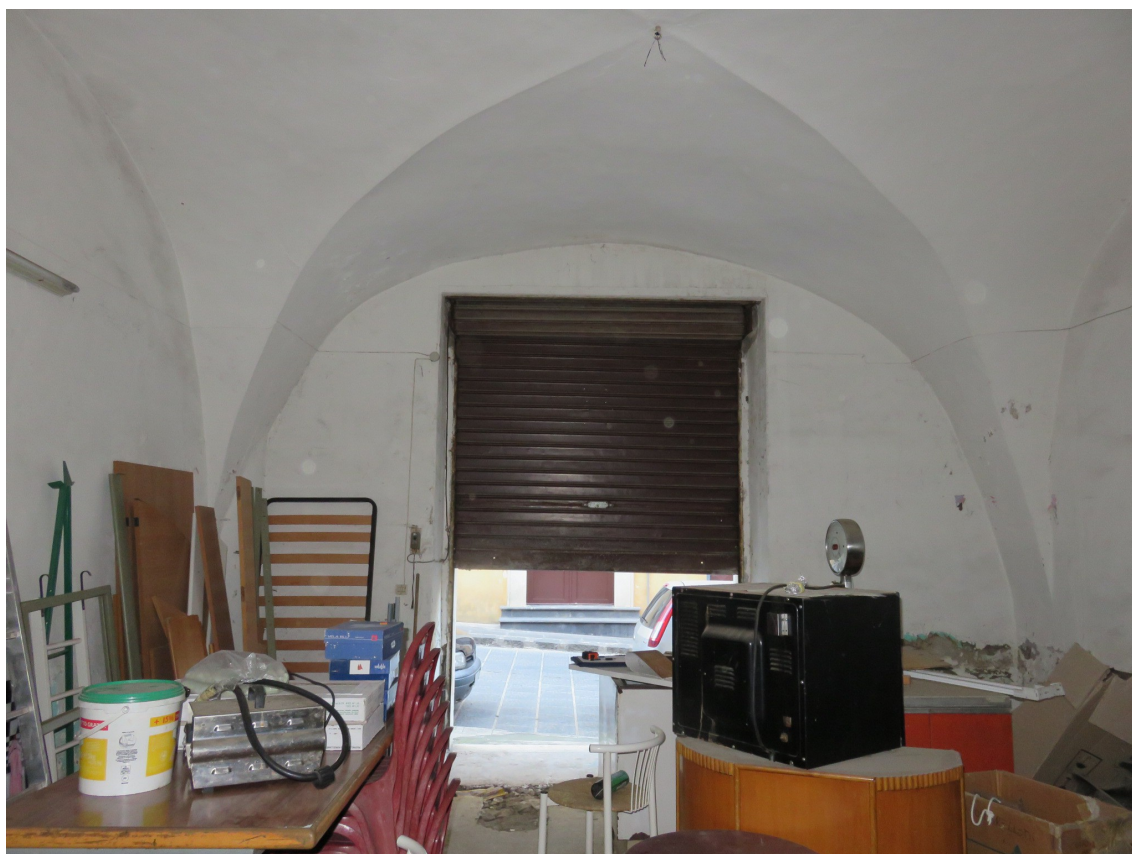
Foto 8 - Laboratorio Artigianale a piano terra
