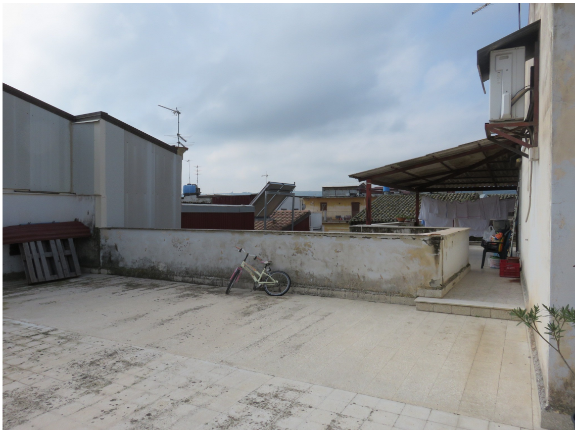
Foto 40 - Terrazzo e tettoia 2° piano
