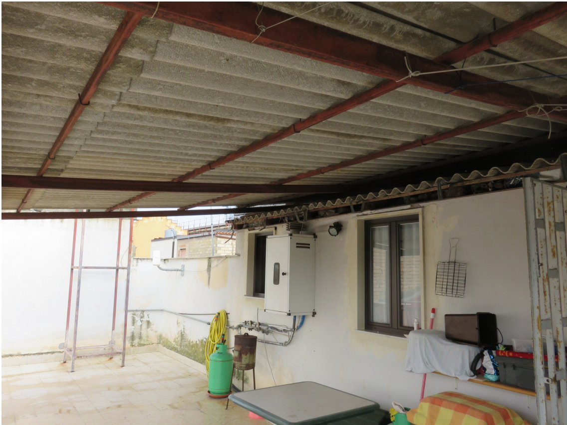
Foto 39 - Terrazzo e tettoia 2° piano
