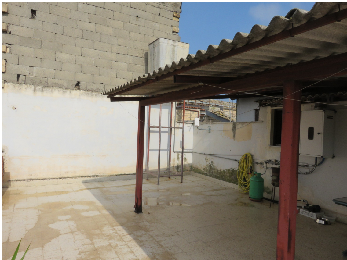
Foto 38 - Terrazzo e tettoia 2° piano
