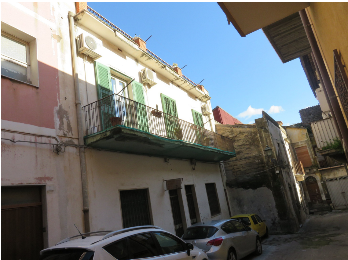
Foto 6 - Prospetto via Nave
