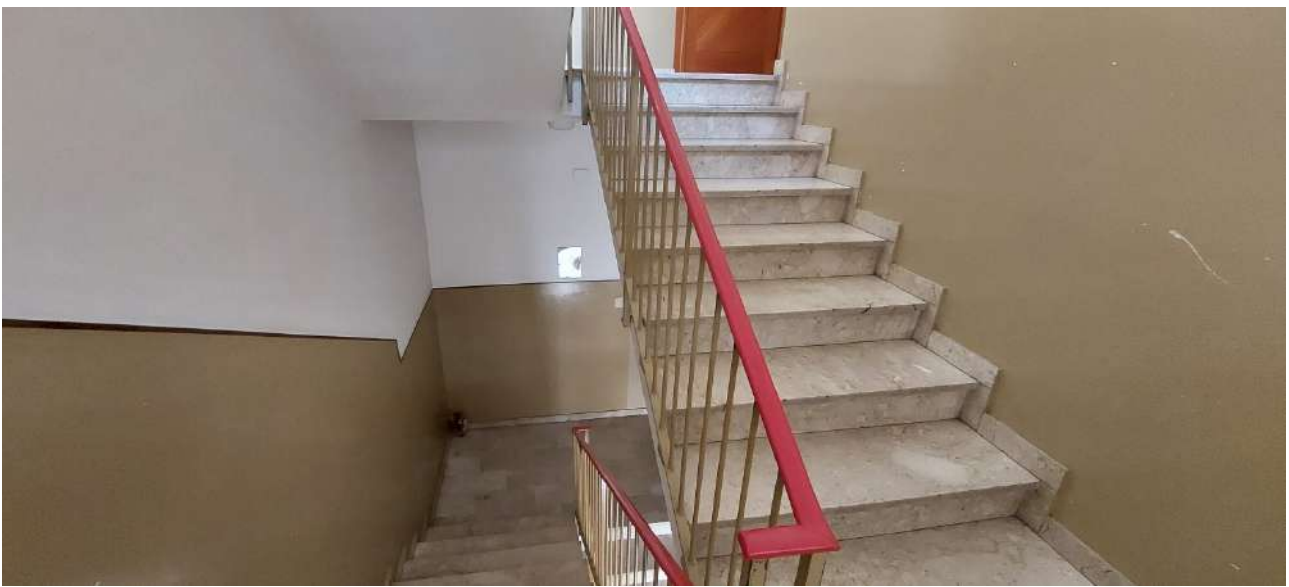
Foto n.ro 7_Vano scala condominiale
