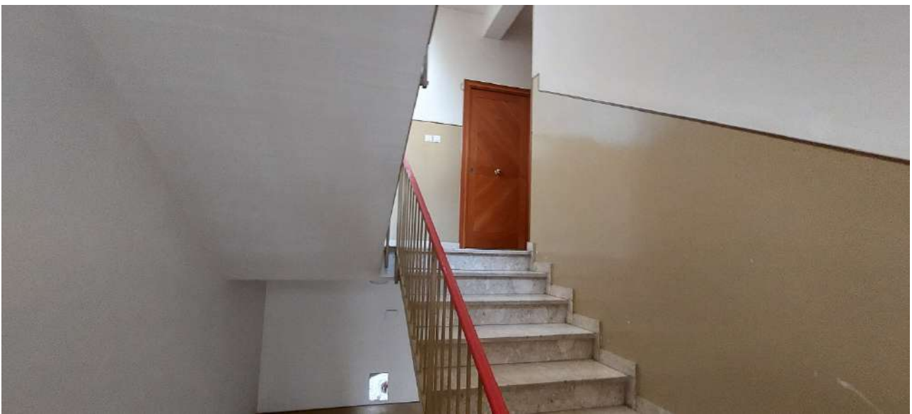
Foto n.ro 8_Vano scala condominiale
