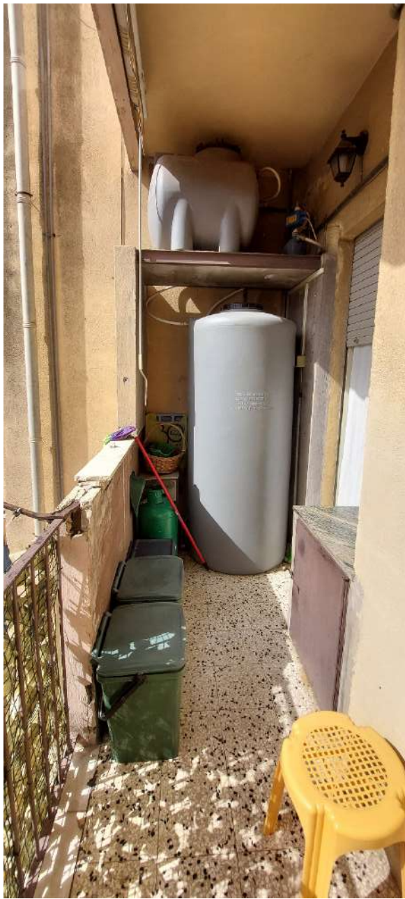
Foto n.ro 35_Balcone
