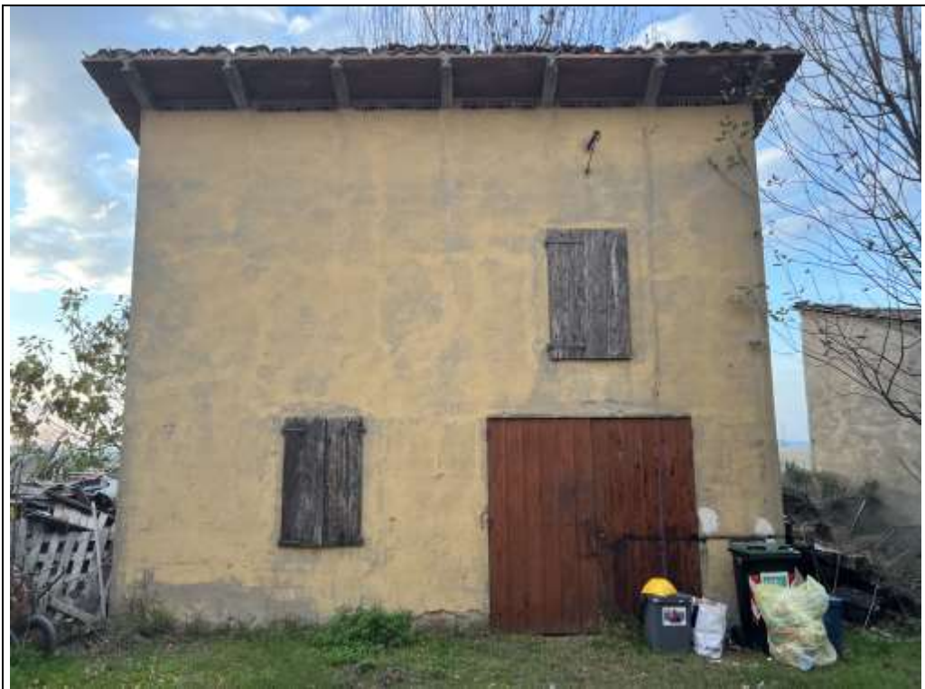
Vista del fabbricato limitrofo ad uso cantina
