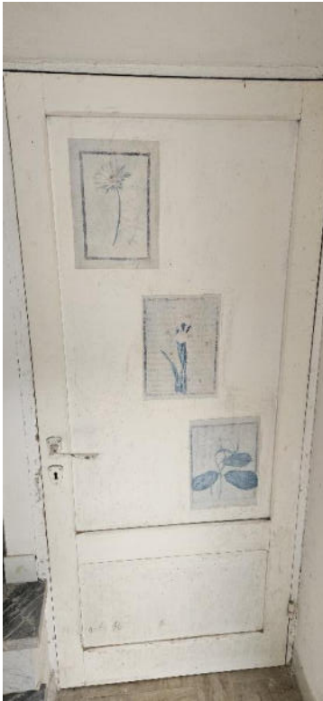
accesso vano scala
