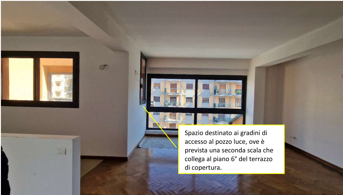
15. Vista dello spazio ove dovrà essere installata la scala.
