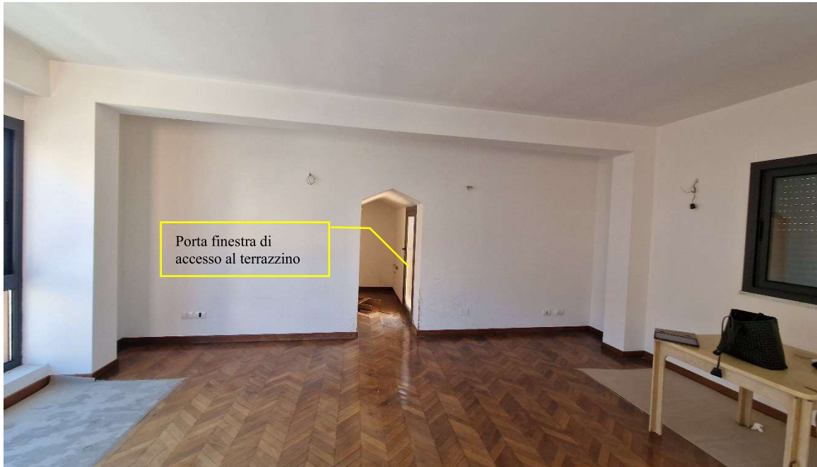
16. Vista del varco di accesso al vano sottotetto con annesso terrazzino.
