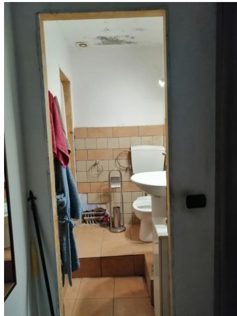
BAGNO AL TERZO PIANO
