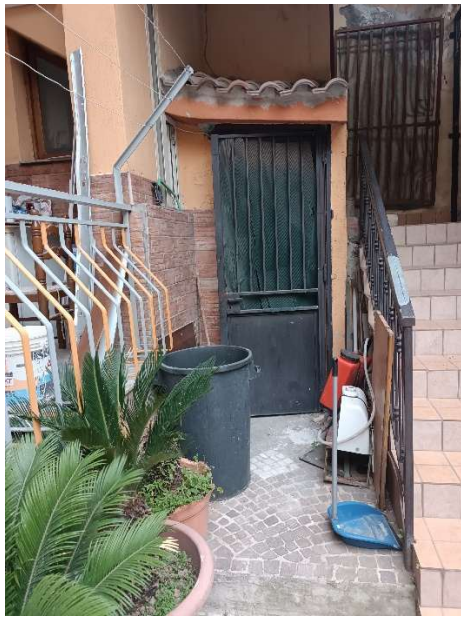
Foto 35. Vano accesso zona interrata
