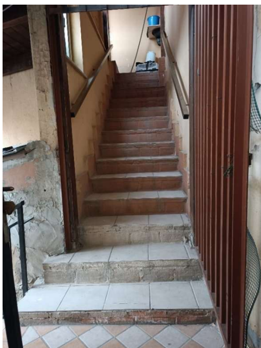
Foto 17. Scala accesso piano primo
