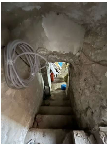
Foto 37. Scale accesso zona interrata
