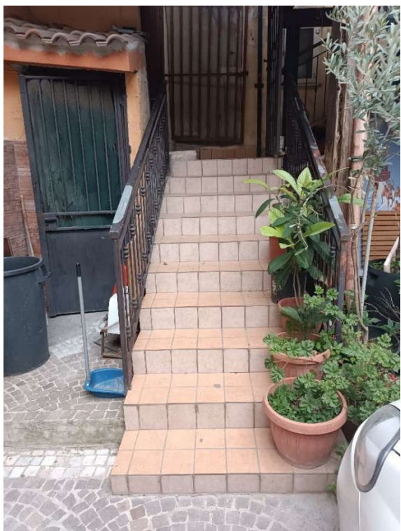
Foto 15. Scala accesso piano primo
