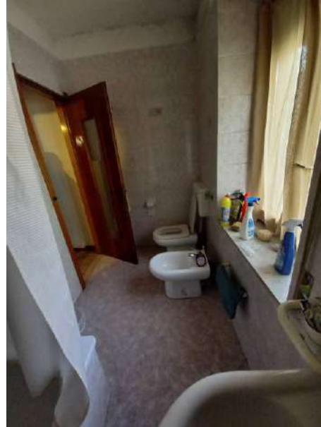
VISTA BAGNO 1°P
