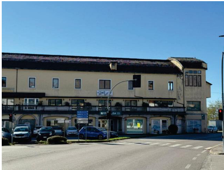
Foto panoramica esterna (nord)
