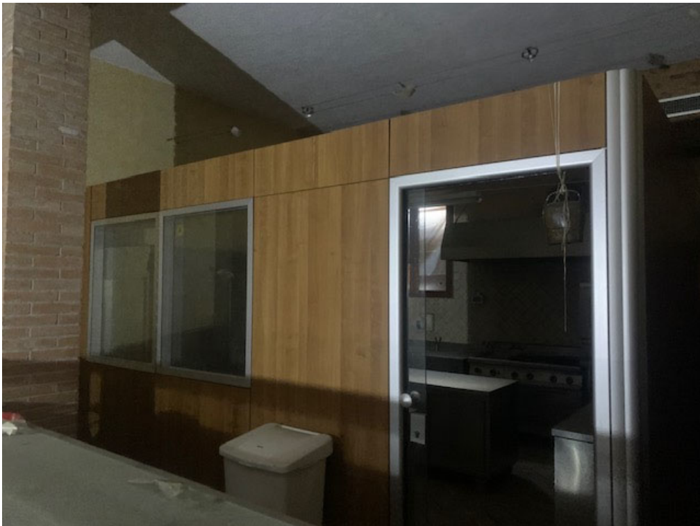
Vista interna sub 17
