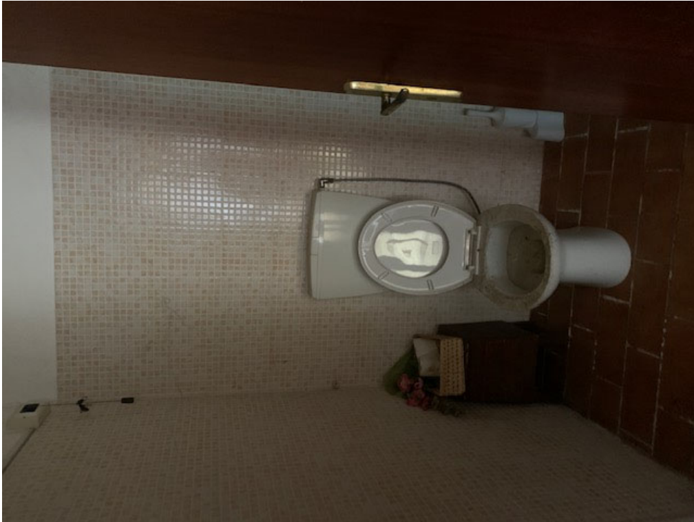
Vista servizio igienico sub 36
