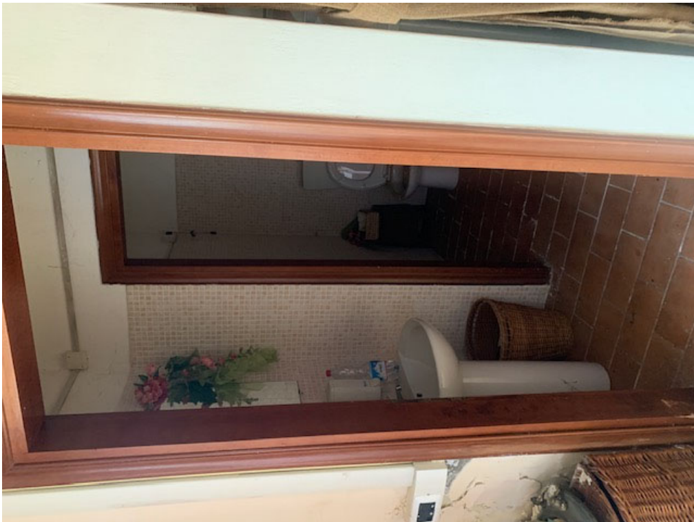
Vista interna sub 36
