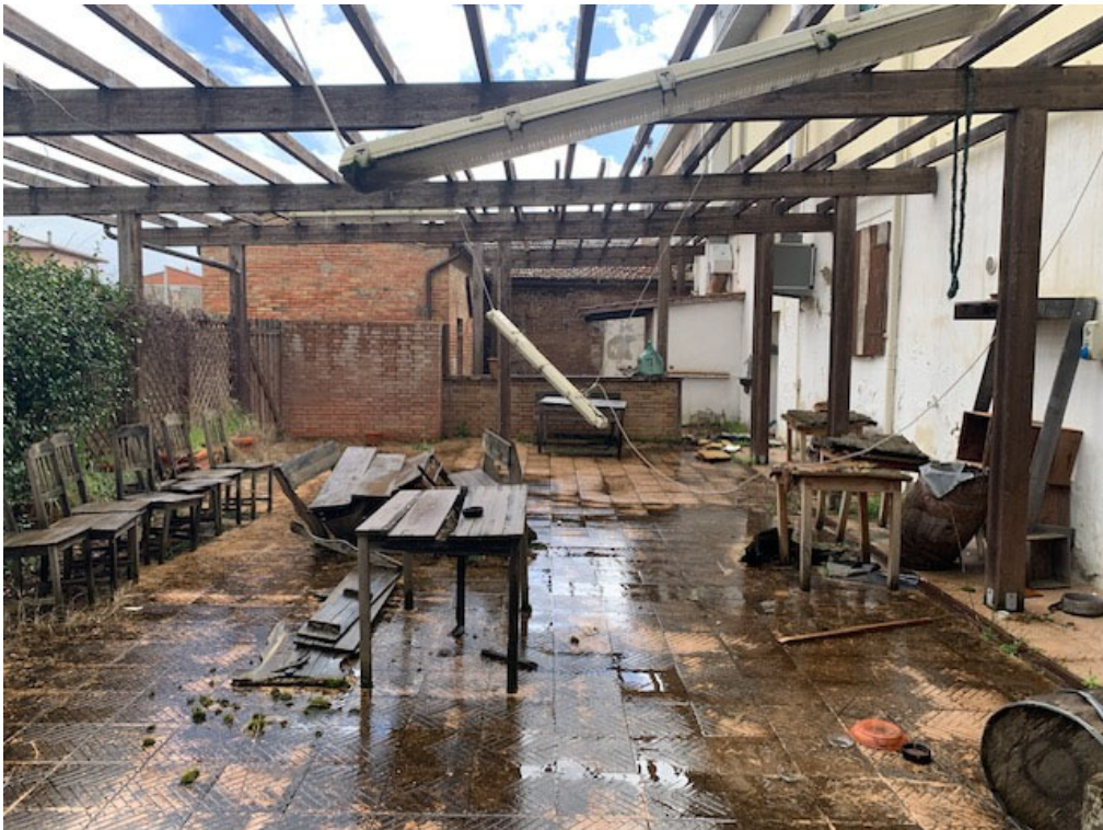
Vista resede sub 37
