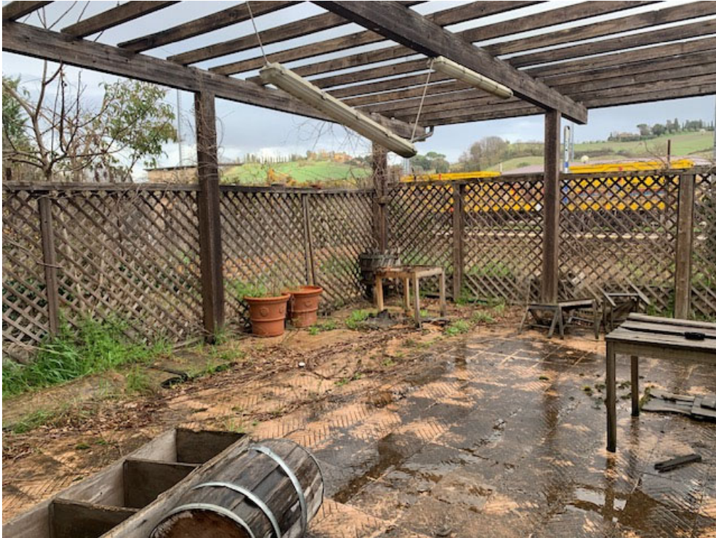
Vista resede sub 37
