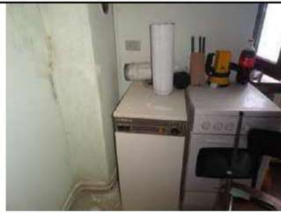
Vista interna finiture abitazione
