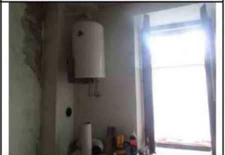
Vista interna finiture abitazione
