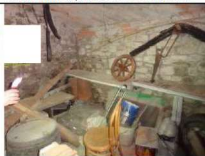
Vista interna cantina
