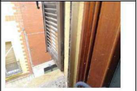
Vista interna finiture abitazione
