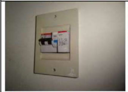
Vista interna finiture abitazione
