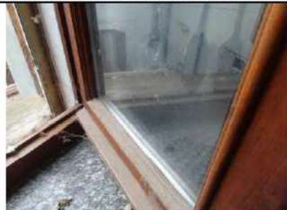
Vista interna finiture, abitazione
