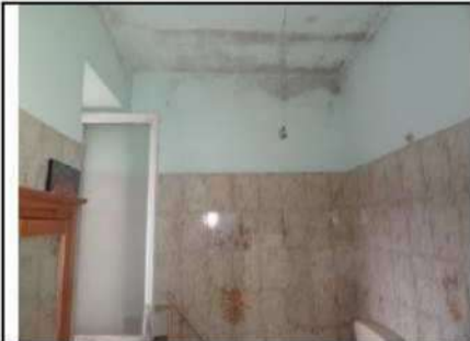
Vista interna abitazione bagno
