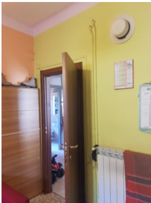
Foto 12 – Locale soggiorno – vista porte ed elementi radianti con tubazioni esterne.
