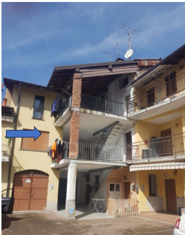
Foto 2 – esterna cortile accesso scala comune – unità posta a piano primo.
