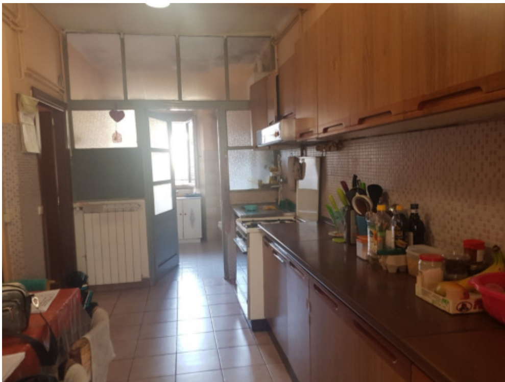
Foto 5 - Disimpegno di ingresso – locale uso cucina – vista accesso al bagno - parete divisoria con parte superiore vetrata.
