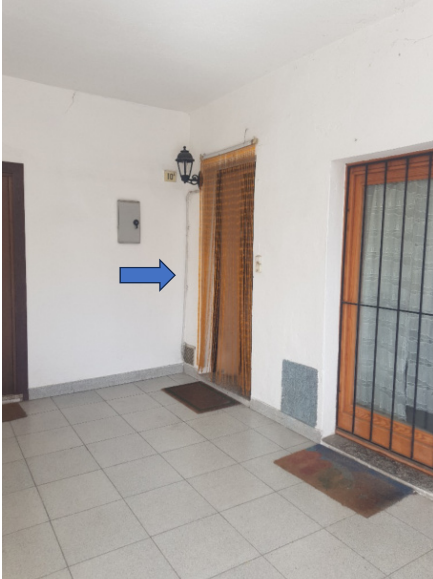
Foto 4 – esterna – parti comuni ingresso unità posta a piano primo.
