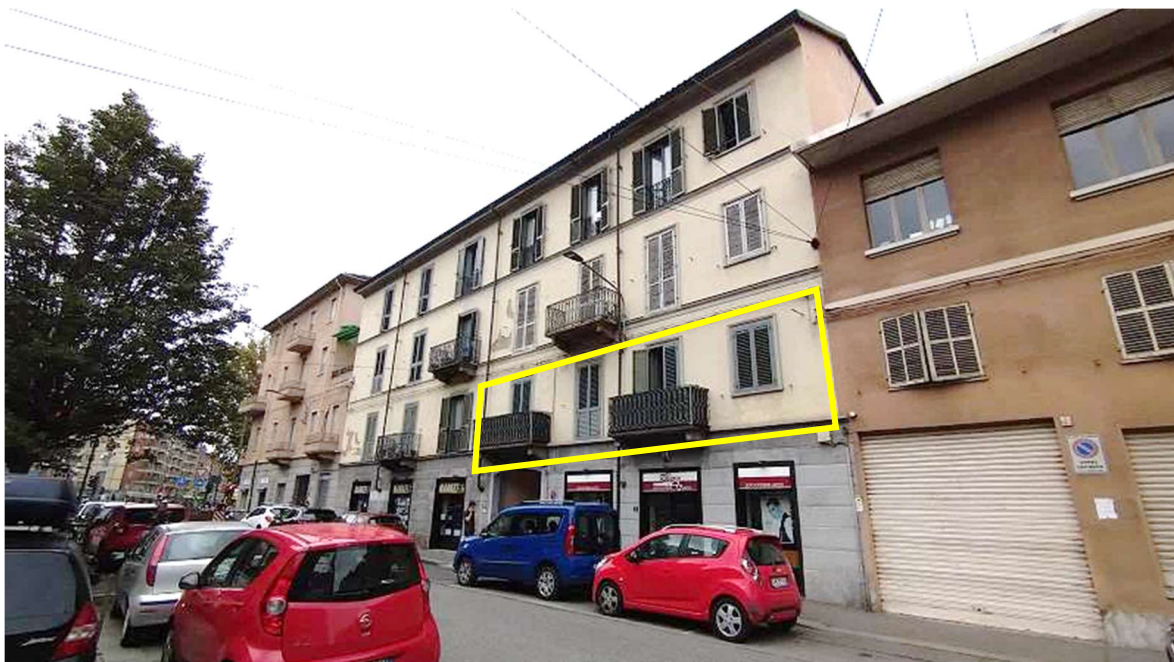
La facciata lato strada: con il contorno giallo si indica l'immobile pignorato
