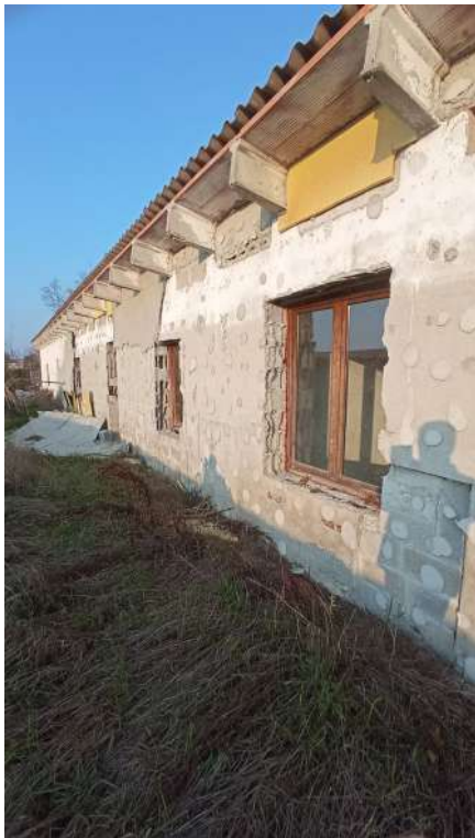
Completo distacco dell'isolamento a cappotto della facciata
