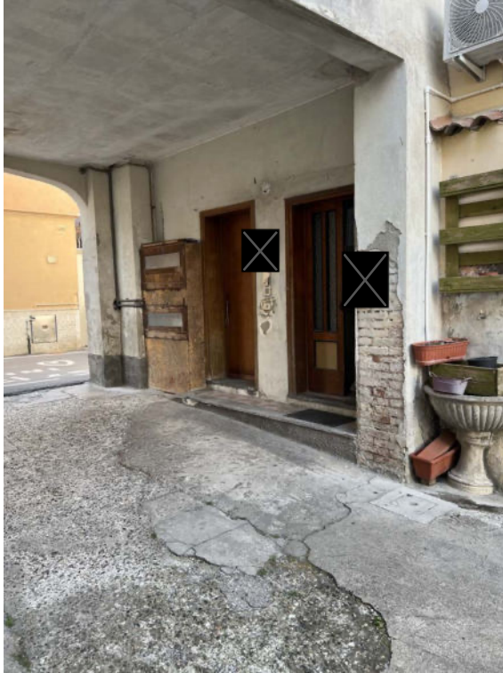
Vista dell'ingresso sotto l'androne
