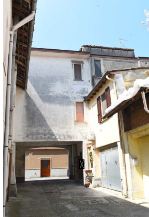
Vista dell'androne dal cortile interno
