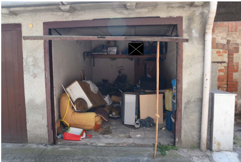
Vista porta basculante di accesso all'autorimessa
