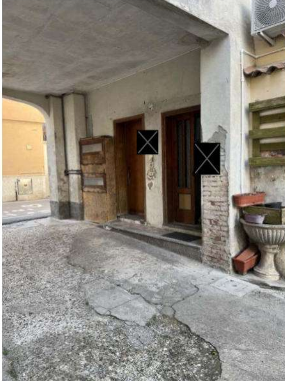
Vista dell'ingresso sotto l'androne
