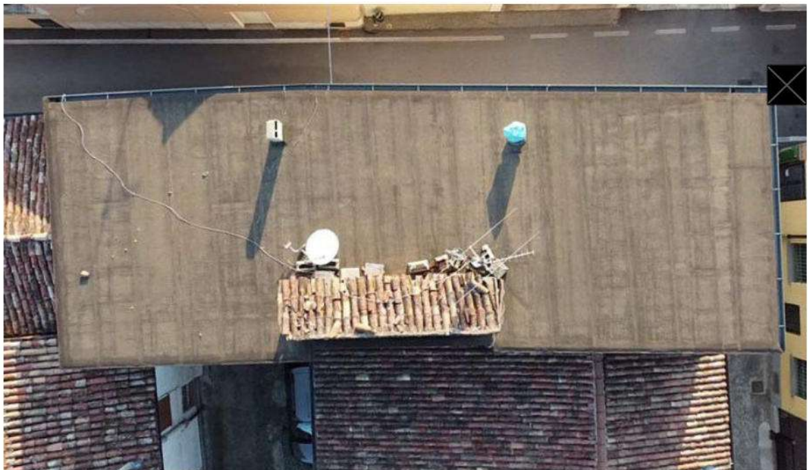
Vista della copertura
