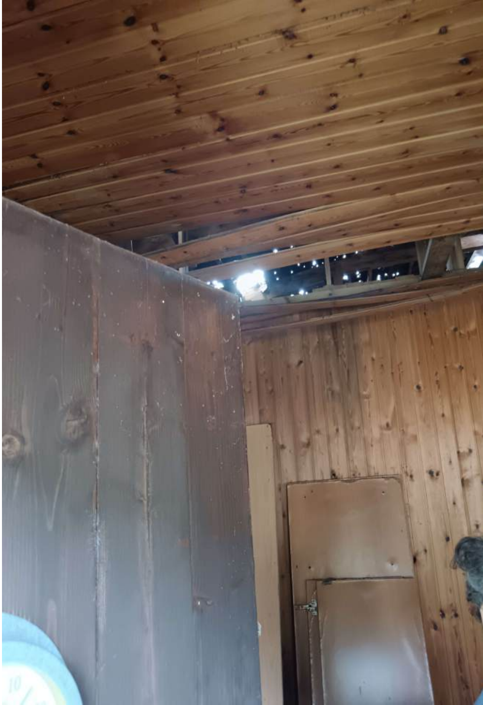
Foto n°12 Particolare del tetto del prefabbricato "D"
