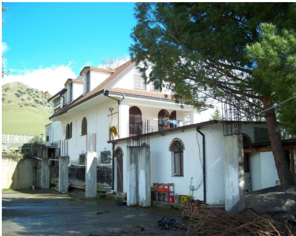
Foto n.5 Fabbricato in corso di costruzione "E"
