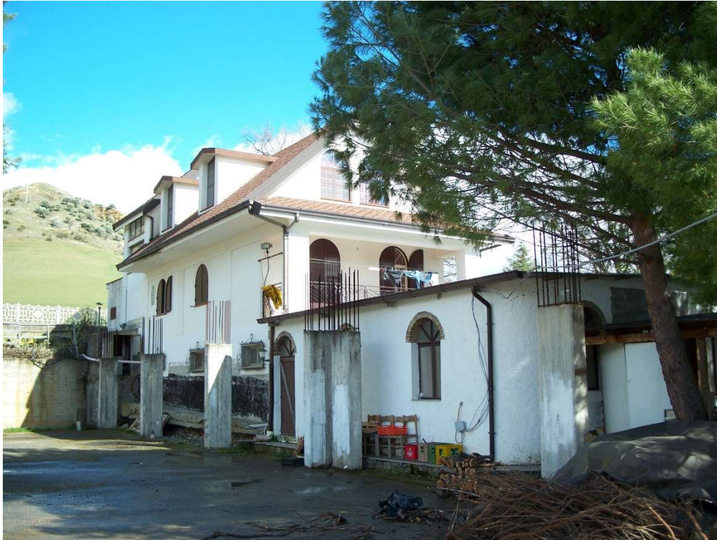
Foto n°3 – Fabbricato “B” e parte del costruendo fabbricato “E”
