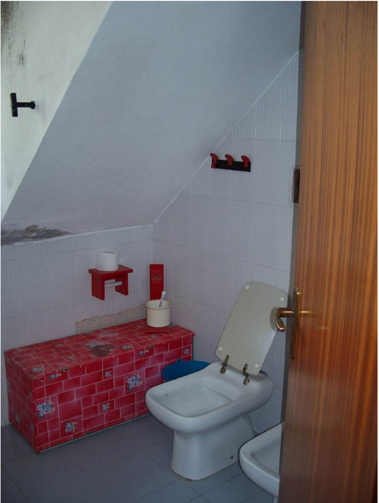
Foto n°10 Particolare del bagno a piano primo
