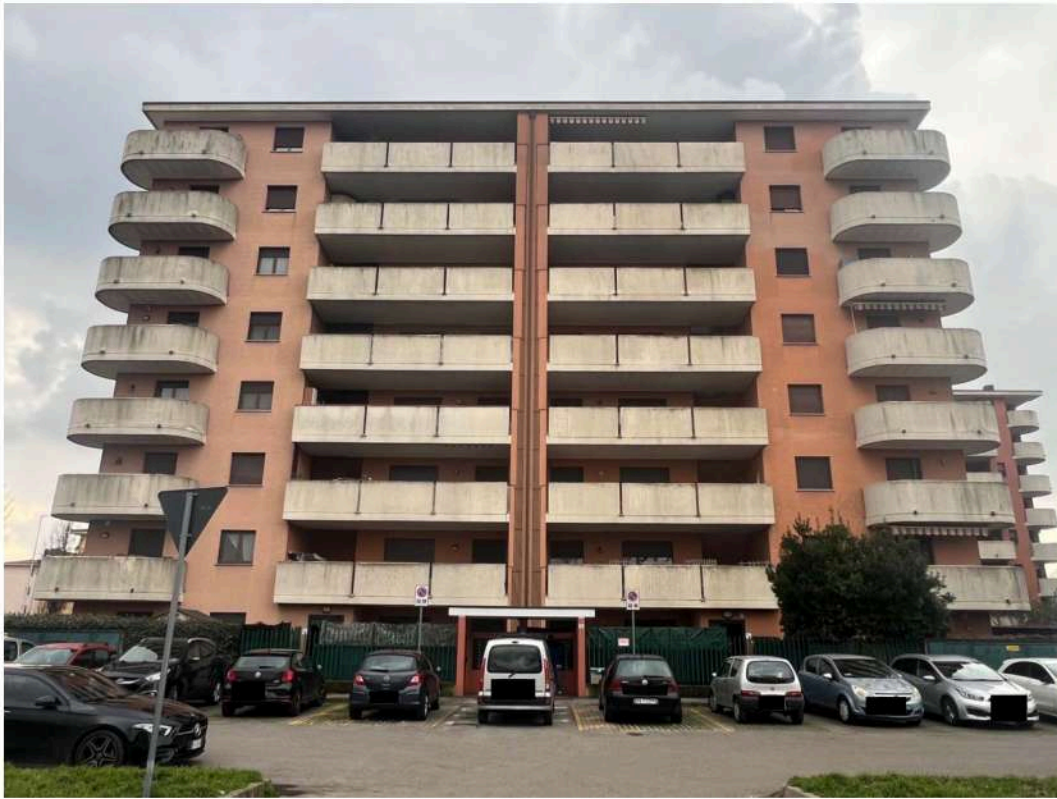
FRONTE NORD-EST in affaccio su Via dei Villini
