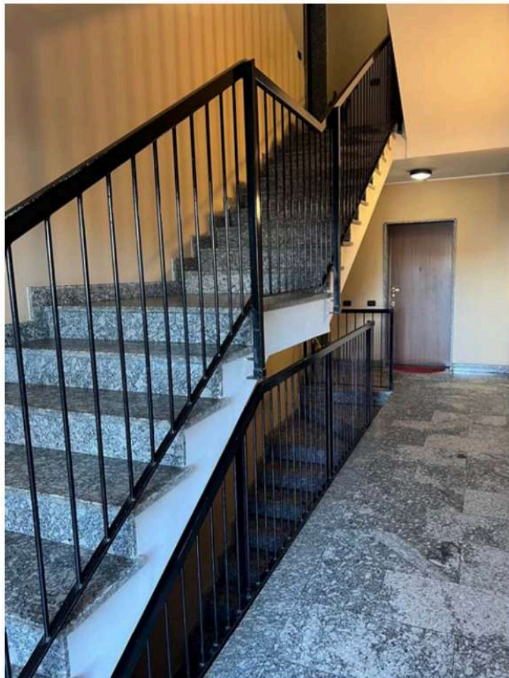
VANO SCALA CONDOMINIALE
