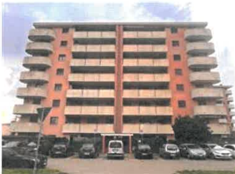
Fronte principale in affaccio su Via dei Villini
