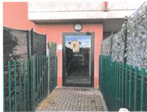
Portoncino ingresso vano scala
