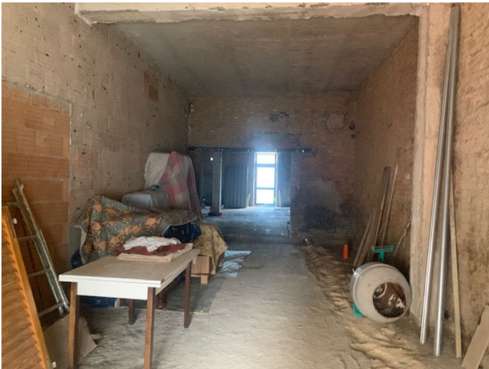
Vista interna porzione sub 39 (ex subb 7 e 8)
