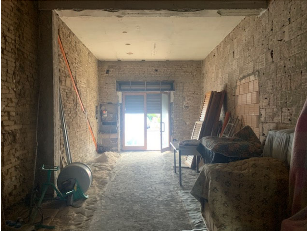
Vista interna porzione sub 39 (ex subb 7 e 8)
