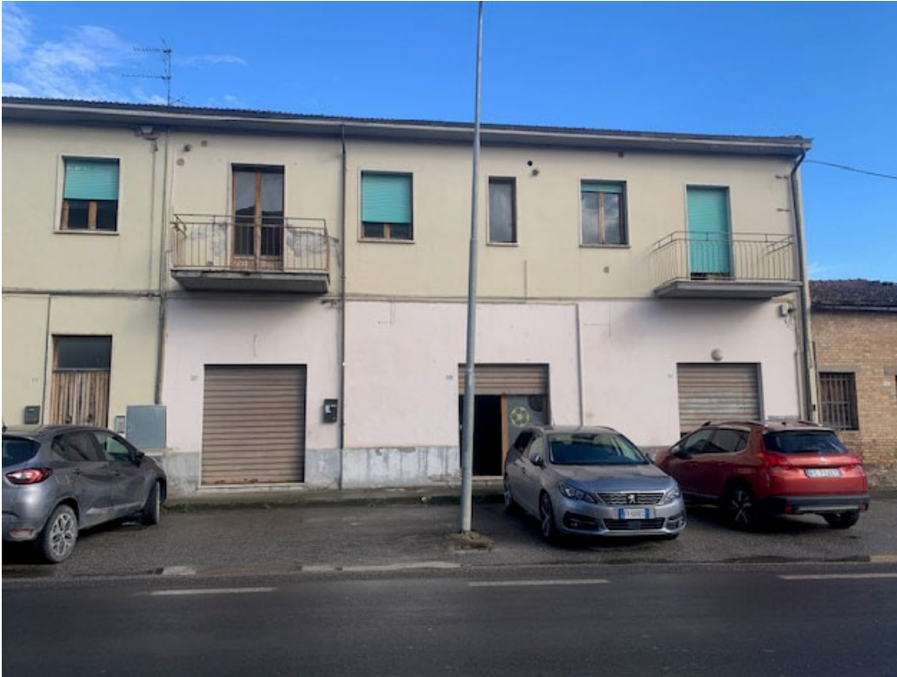
Vista esterna ingresso nc.19-21 subb 39-40
