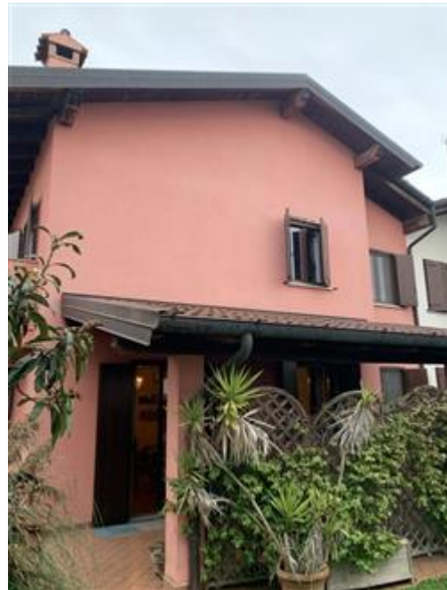
Vista prospettica tettoia pertinenziale in lato ovest
