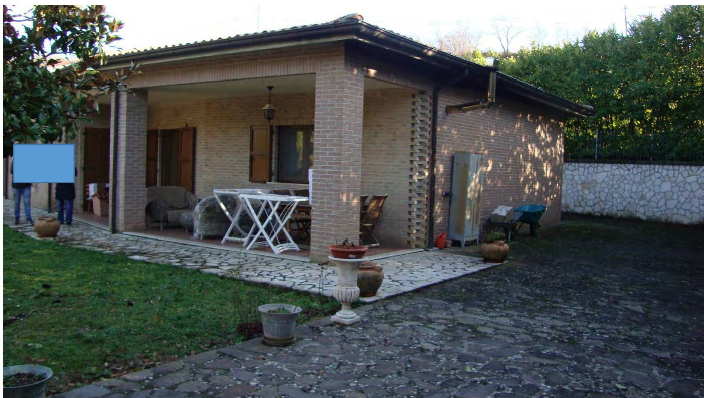
FOTO N. 11 – PORZIONE DI PROSPETTO NORD-OVEST DEL FABBRICATO U.I.U. SUB. 3
