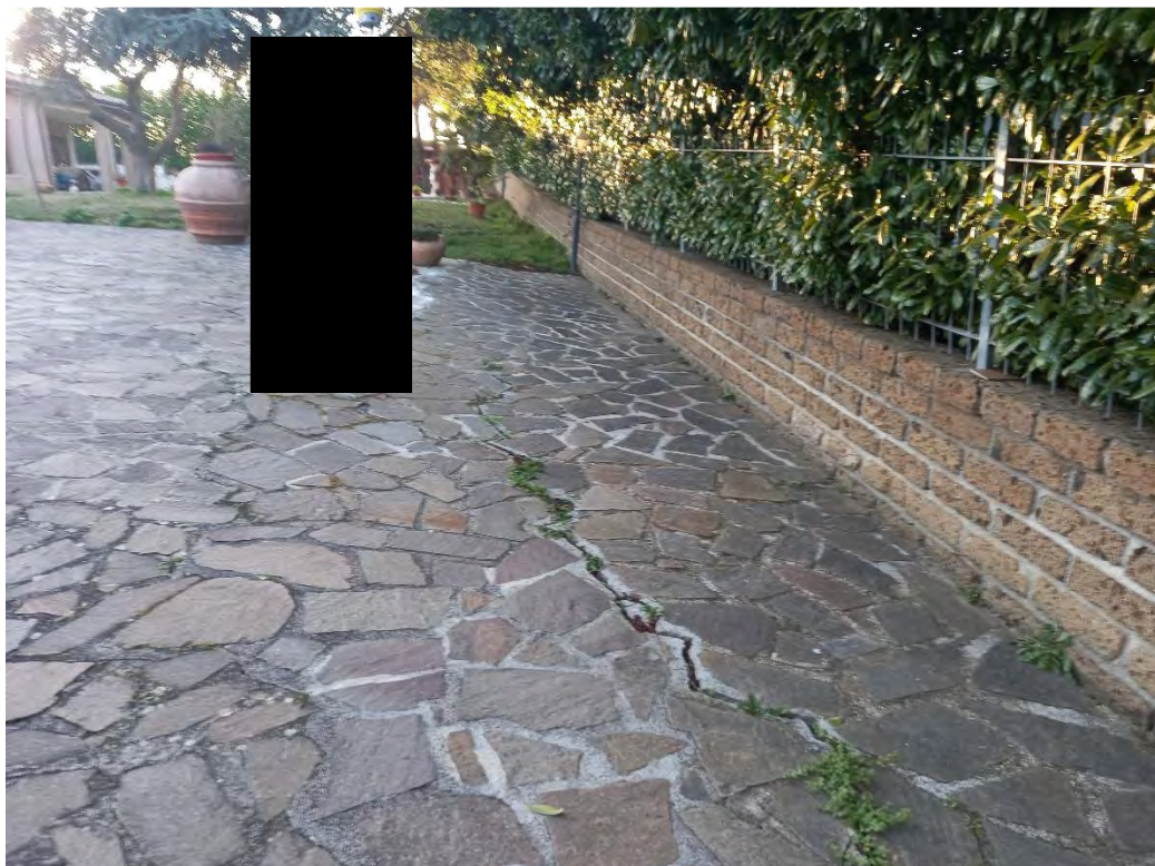
FOTO N. 4 – PAVIMENTAZIONE ESTERNA AL FABBRICATO NELL'AREA RECINTATA
