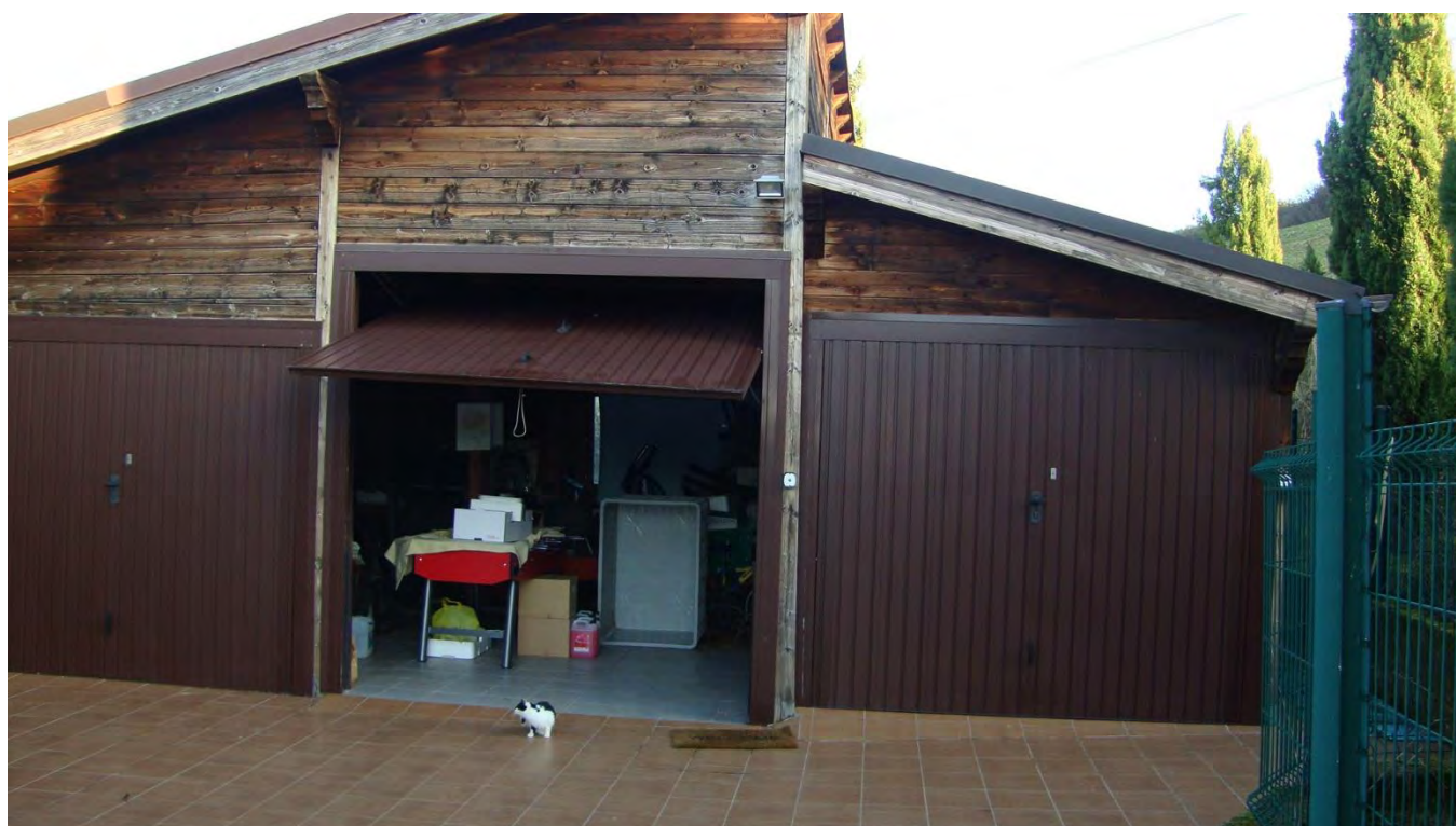
FOTO N. 14 – PROSPETTO OVEST DEL LOCALE AUTORIMESSE - U.I.U. SUB. 6
