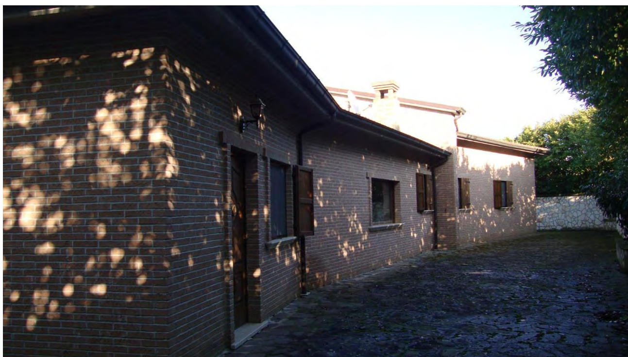
FOTO N. 12 –PROSPETTO NORD DEL FABBRICATO U.I.U. SUB. 3 e 8
