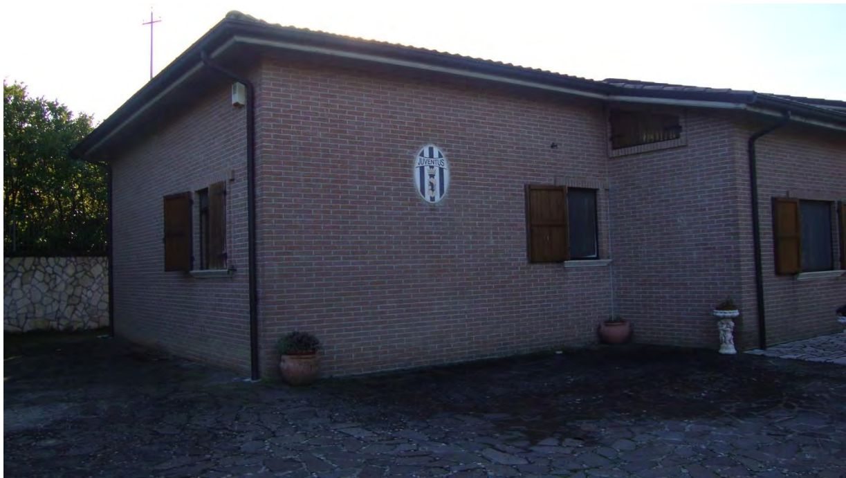
FOTO N. 7 – PORZIONE DI PROSPETTO NORD-EST DEL FABBRICATO U.I.U. SUB. 8
