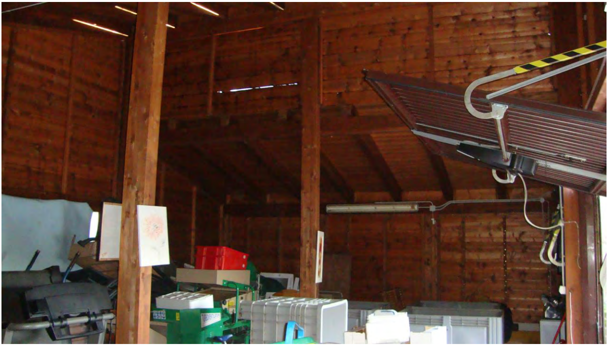
FOTO N. 31 – LOCALE AUTORIMESSE - U.I.U. SUB. 6
