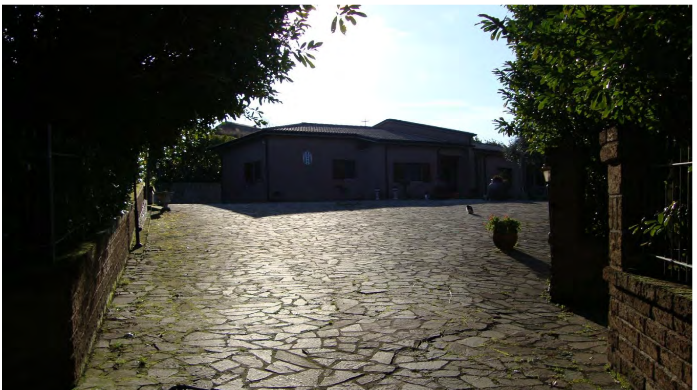
FOTO N. 6 – PAVIMENTAZ. ESTERNA AL FABBRIC NELL'AREA RECINTATA, SULLO SFONDO IL FABBRICATO
