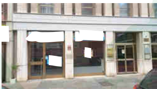
Vista fronte ovest su Via Verdi
