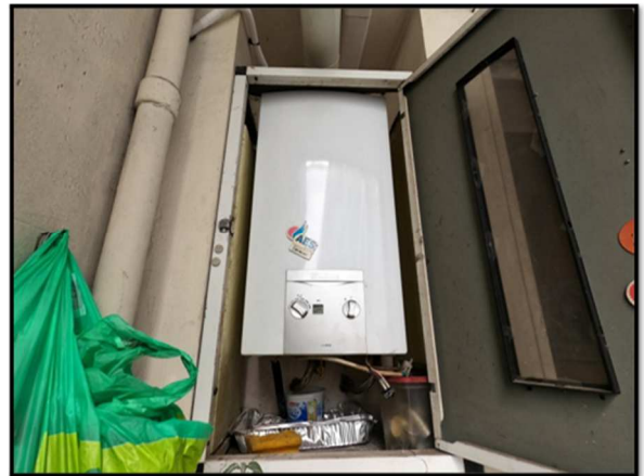
Foto 15 – 16 Balcone e generatore per acqua calda sanitaria
