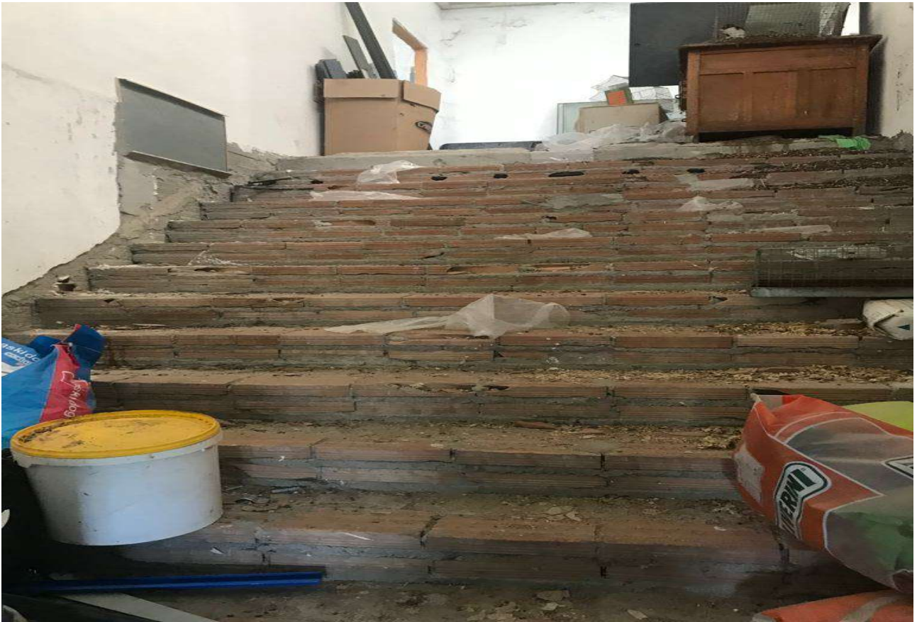
Scala per piano primo
