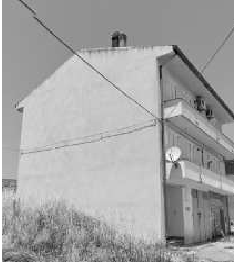
Vista lato sud dell'edificio contenente l'u.iu. descritta
