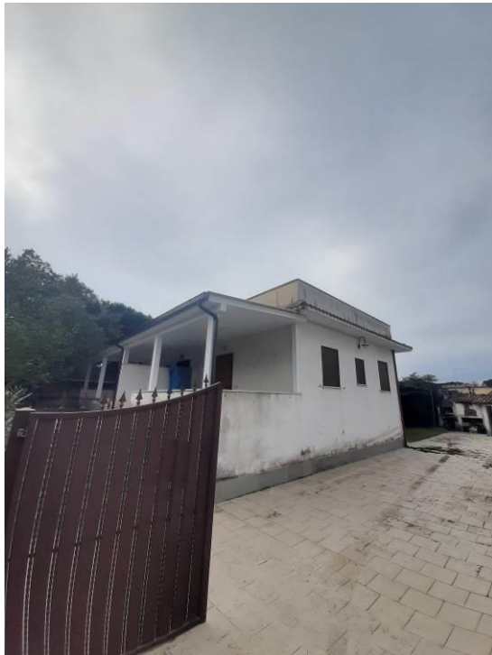
Ingresso – Via Urania n. 85
