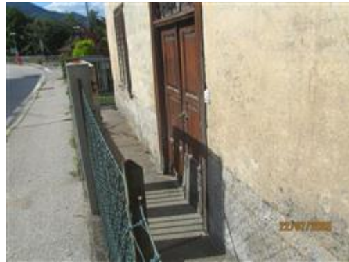
VISTA EDIFICIO LATO SUD-OVEST FRONTE STRADA
