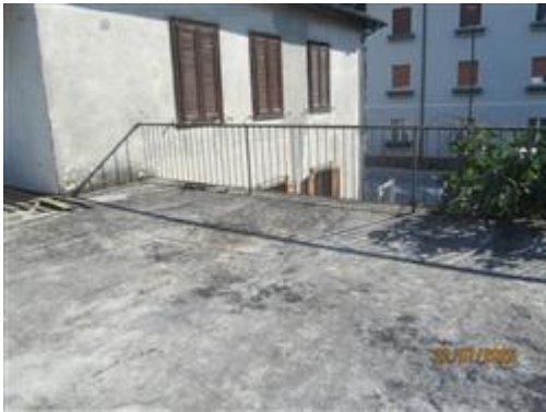
vista esterna su solaio di copertura garage (terrazza p.m.2)
