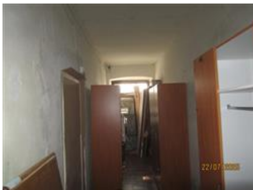
corridoio comune di accesso a piano terra
