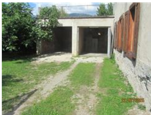
GARAGE (LATO A DESTRA)
