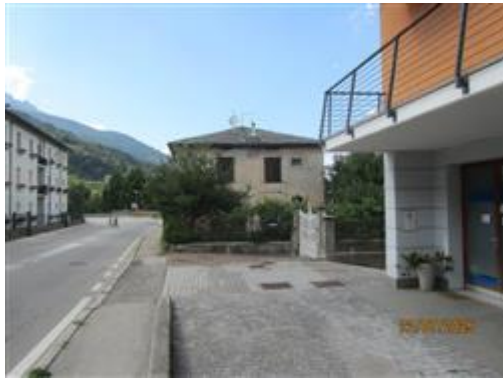
VISTA EDIFICIO LATO SUD-EST
