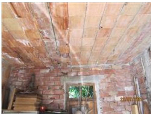
vista interna su solaio di copertura garage p.m.2
