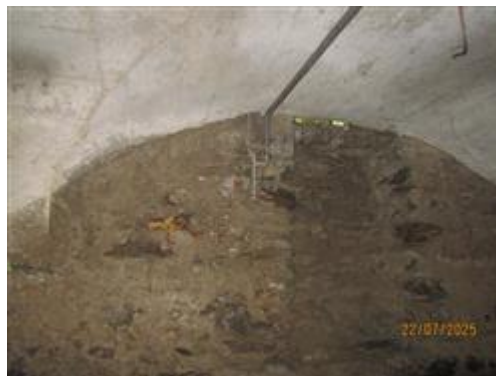
cantina comune a piano interrato
