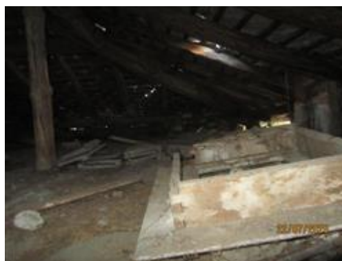
soffitta comune priva di scale fisse d'accesso
