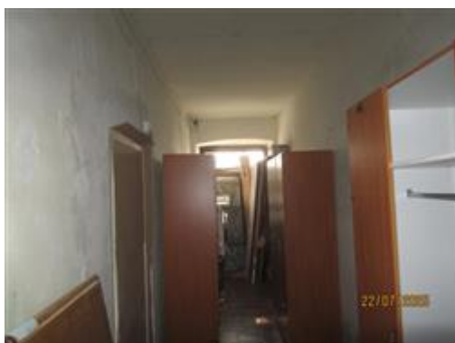
corridoio comune a piano terra
