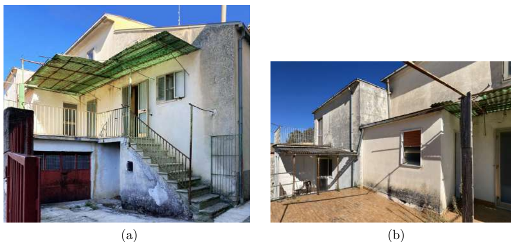
Figura 14: Vista esterna dell'unità abitativa censita in catasto al fg.26 part.lla n.225 sub 5 e part.lla n.226 sub 3: accesso all'abitazione(a), terrazzo di pertinenza(b).
