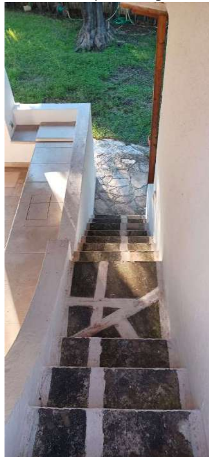
Vista della rampa di scala esterna
