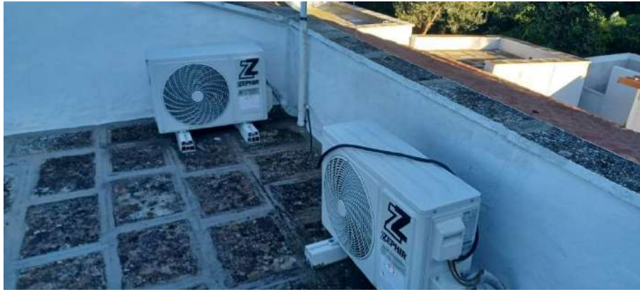
Vista del solaio di copertura
