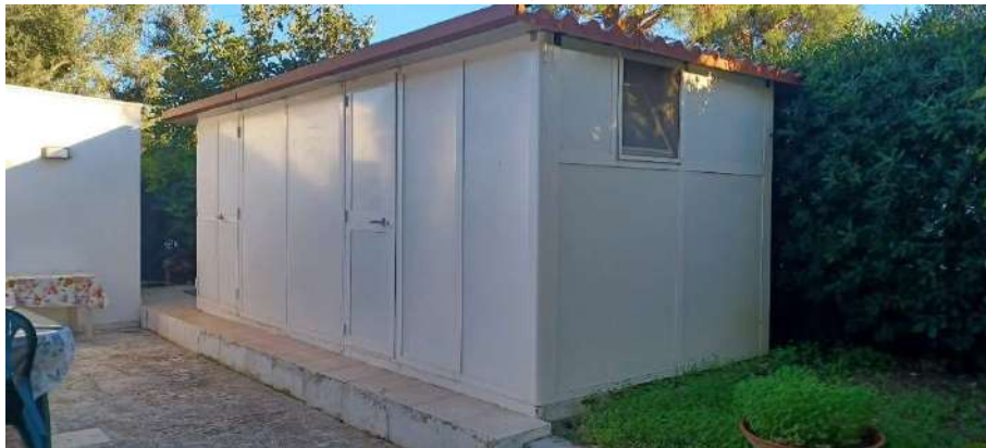
Vista del prefabbricato
