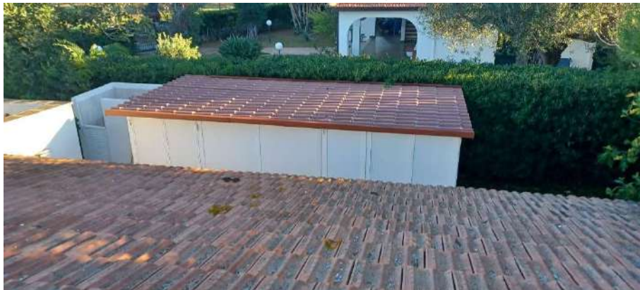
Vista dall'alto del prefabbricato
