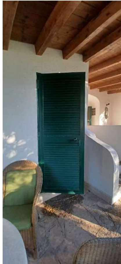
Vista esterna della porta d'ingresso lato sx
