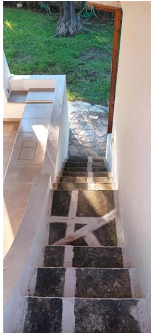
scala di accesso alla copertura
