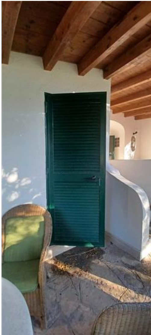
ingresso corpo aggiunto protetto da tettoia in legno
