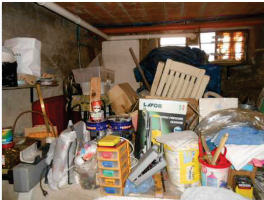
Foto 44 locale cantina / caldaia
