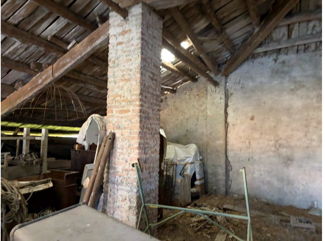
Foto 33. Particolare interno del fienile visto dal granaio
