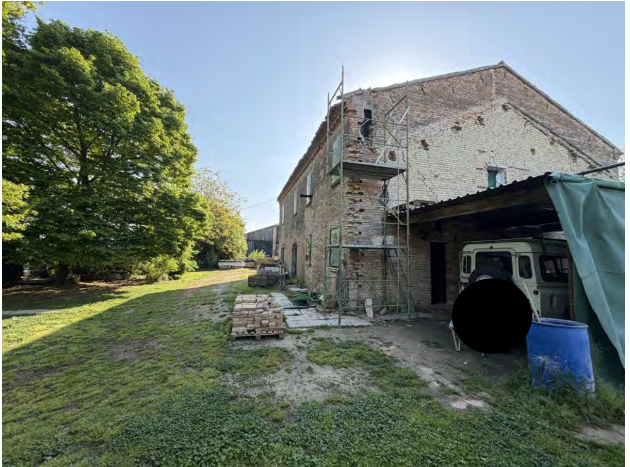
Foto 8. Vista dell'abitazione con tettoia realizzata al posto della porzione demolita
