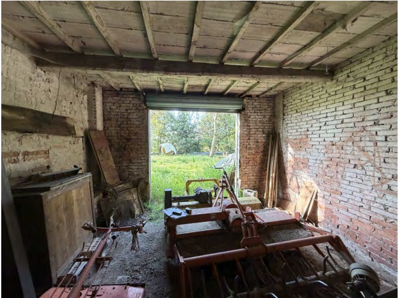
Foto 28. Vista interno del fienile. Magazzino
