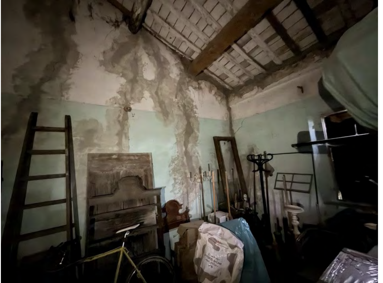
Foto 16. Interno abitazione piano primo
