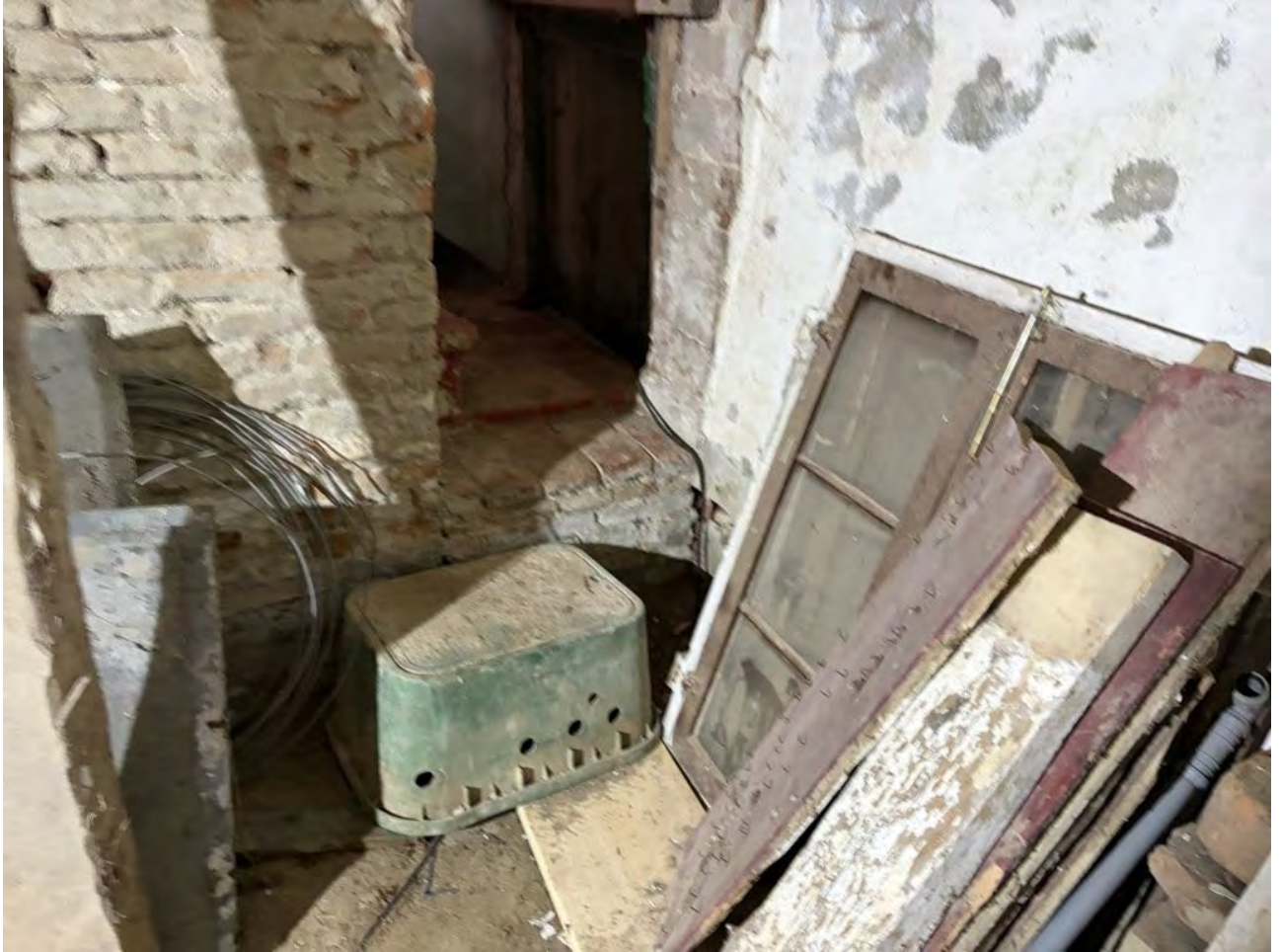
Foto 15. Interno abitazione piano terra
