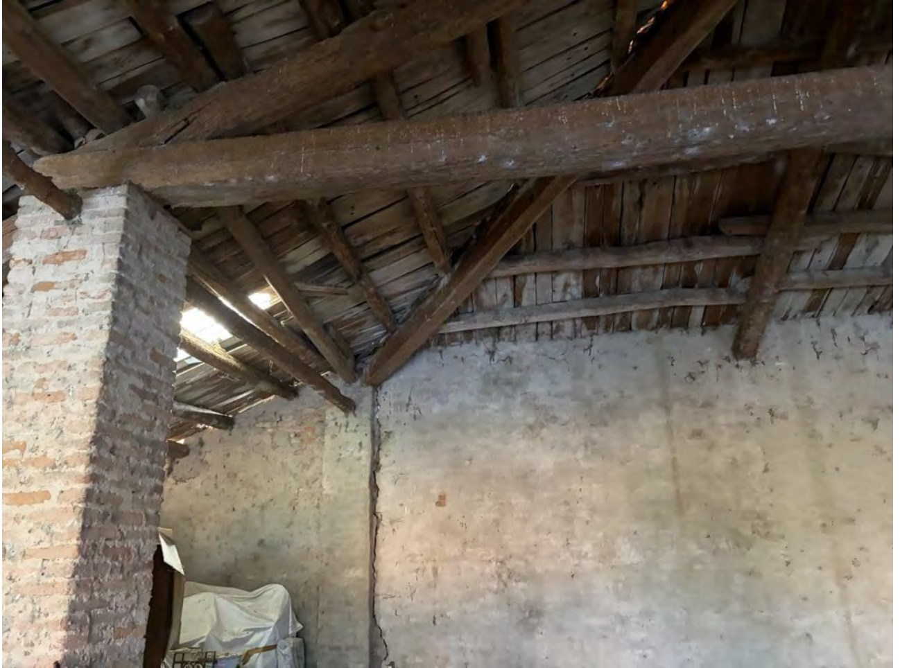
Foto 34. Particolare interno del fienile visto dal granaio
