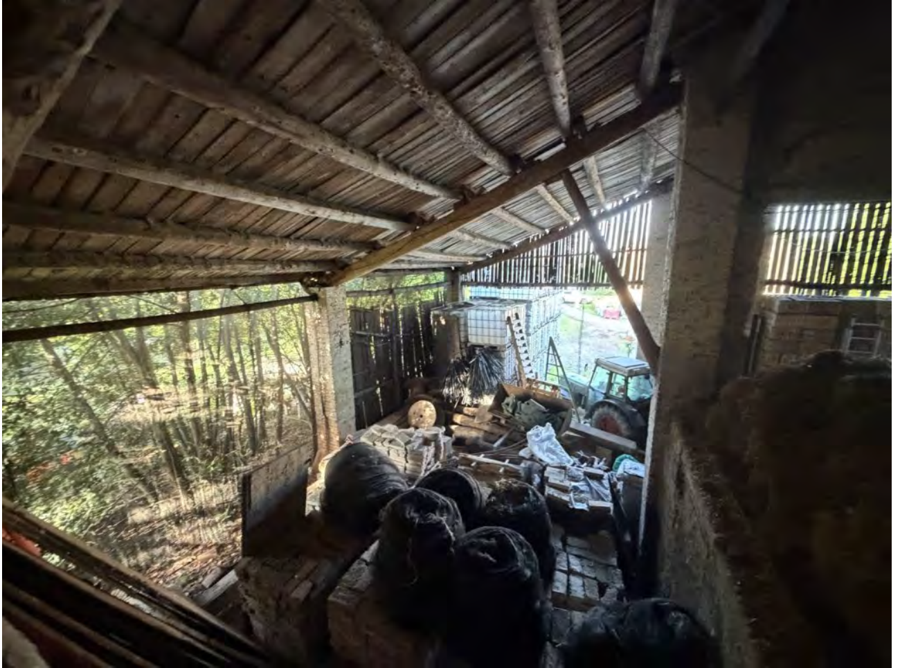
Foto 38. Particolare interno del fienile visto dal granaio
