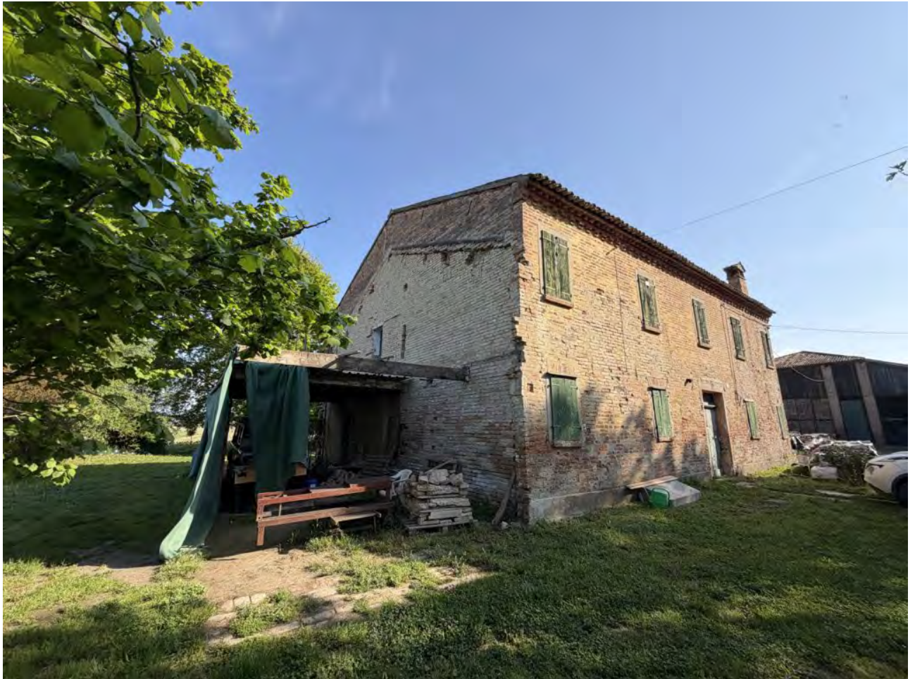
Foto 7. Vista dell'abitazione con tettoia realizzata al posto della porzione demolita
