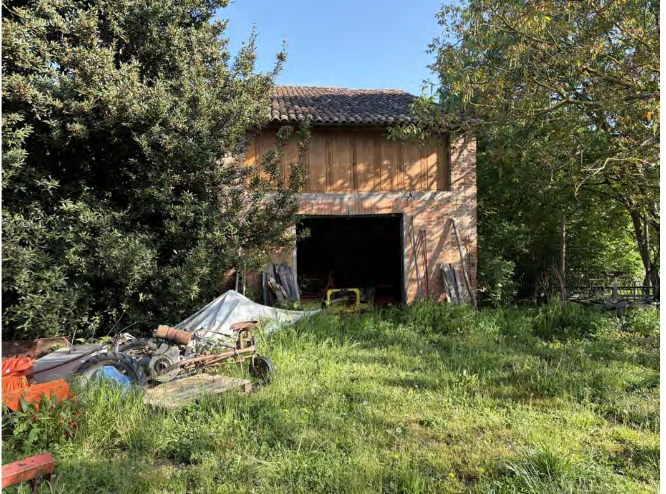
Foto 21. Vista del fienile
