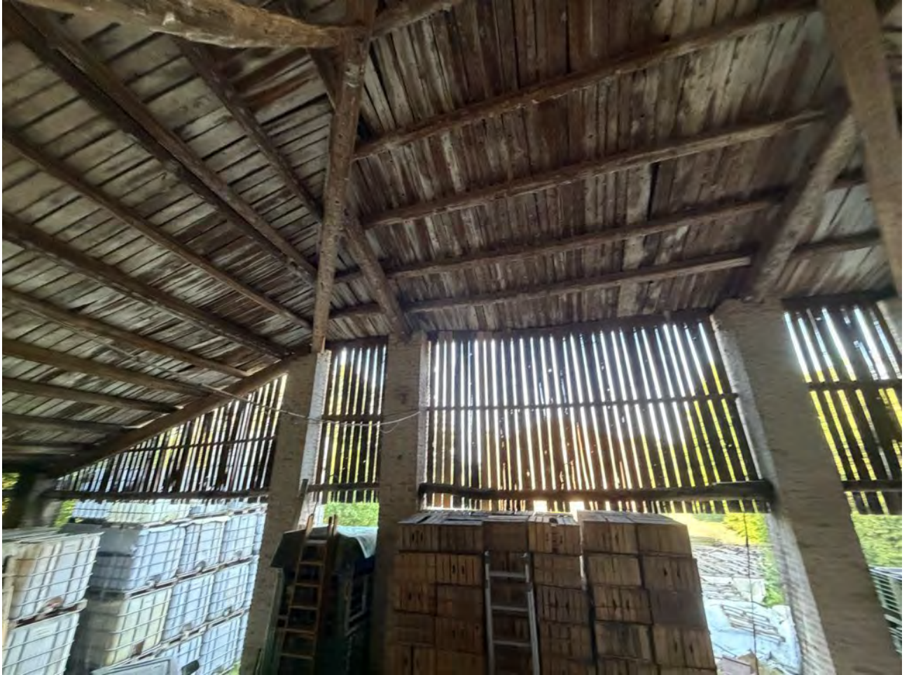
Foto 36. Particolare interno del fienile visto dal granaio
