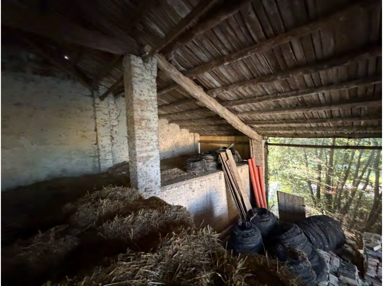
Foto 37. Particolare interno del fienile visto dal granaio
