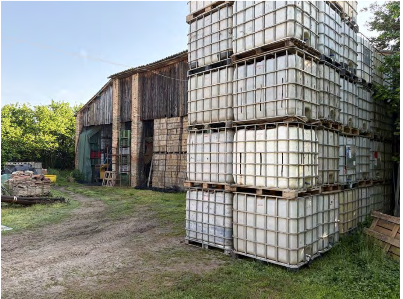
Foto 22. Vista del fienile
