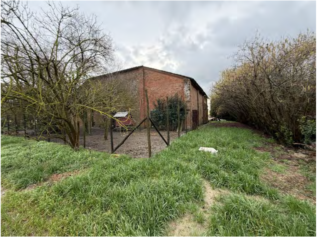
Foto 20. Vista del fienile
