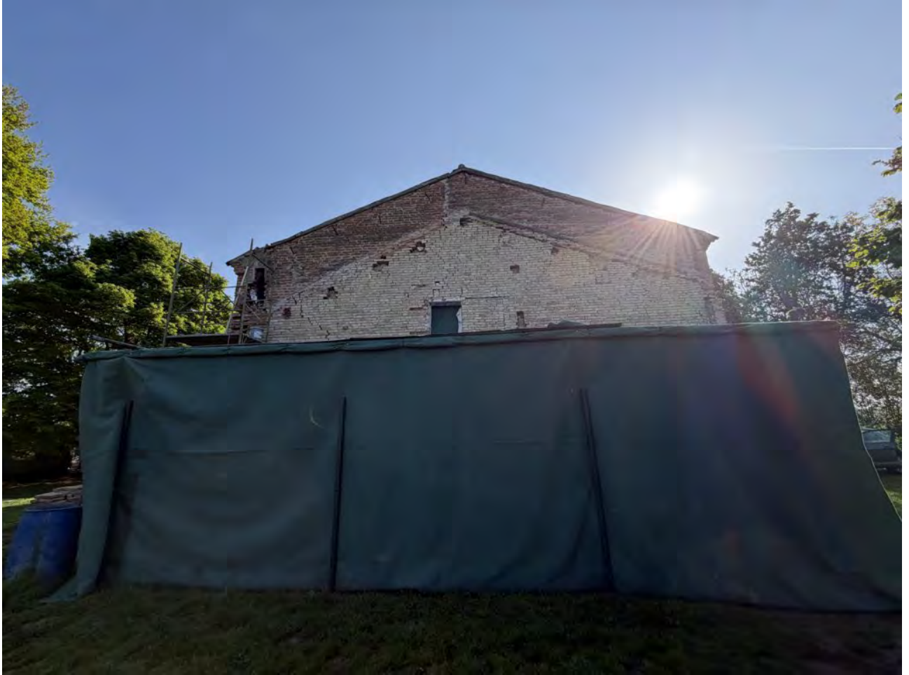
Foto 6. Fianco dell'abitazione con porzione demolita
