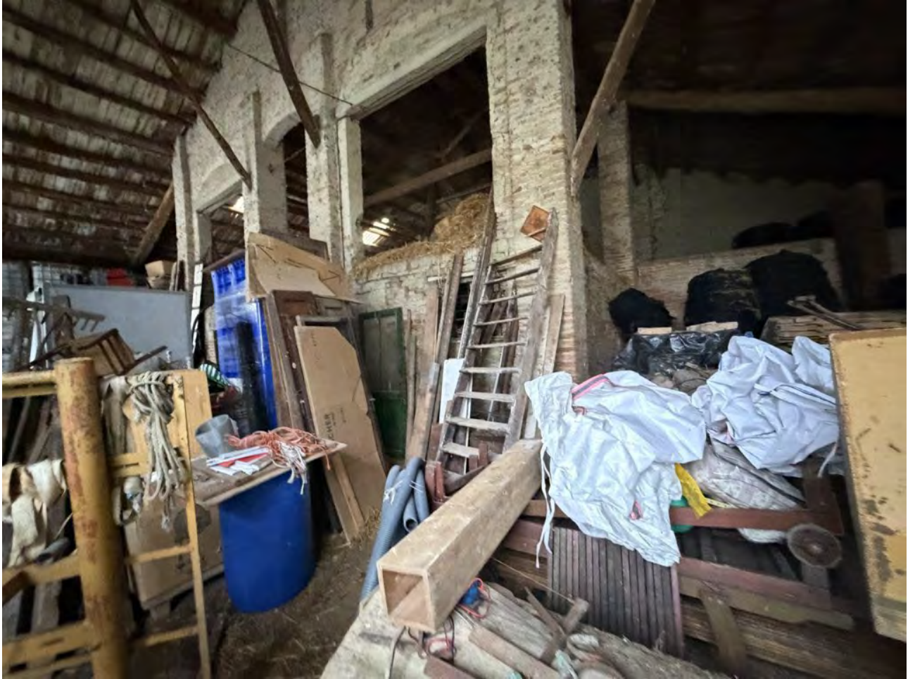
Foto 23. Particolare interno fienile
