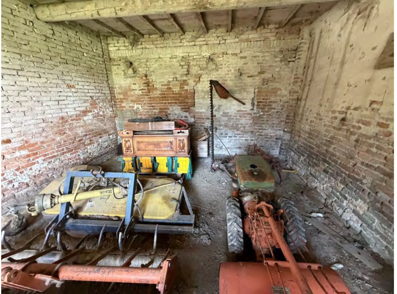
Foto 29. Vista interno del fienile. Magazzino
