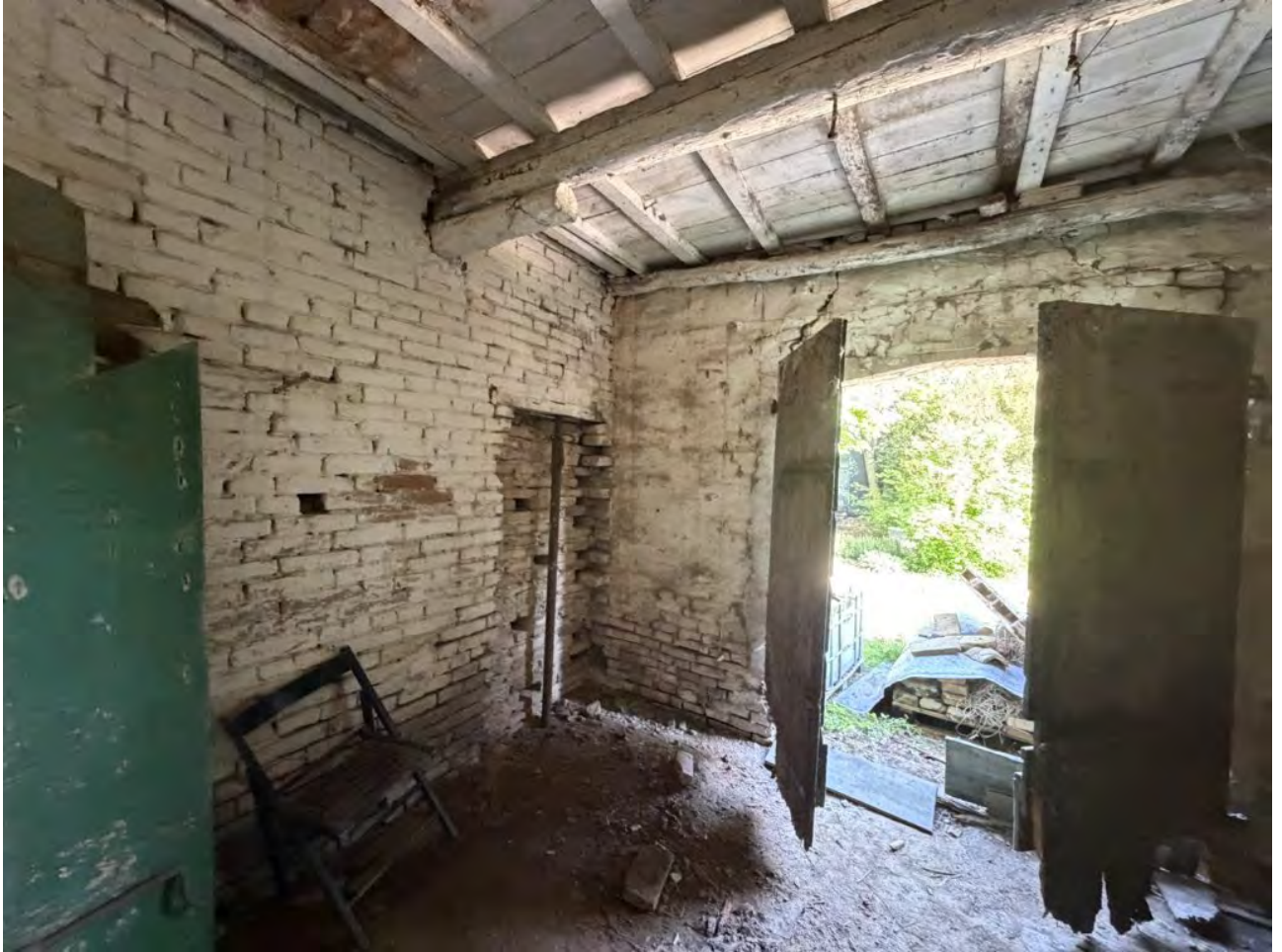
Foto 18. Vista dell'interno dell'abitazione. Magazzino al piano terra
