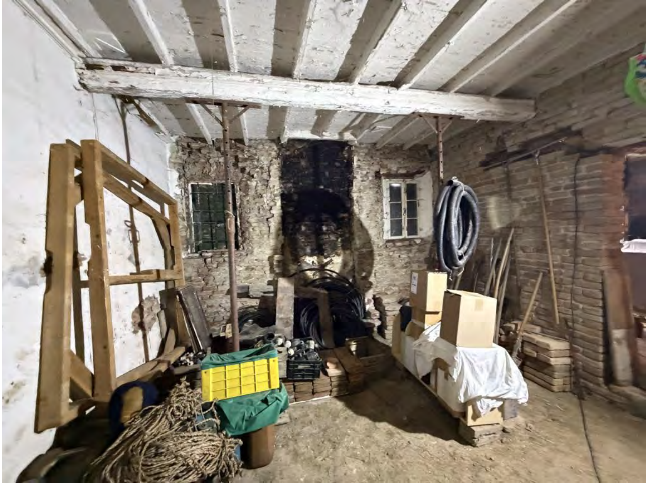
Foto 11. Interno abitazione piano primo
