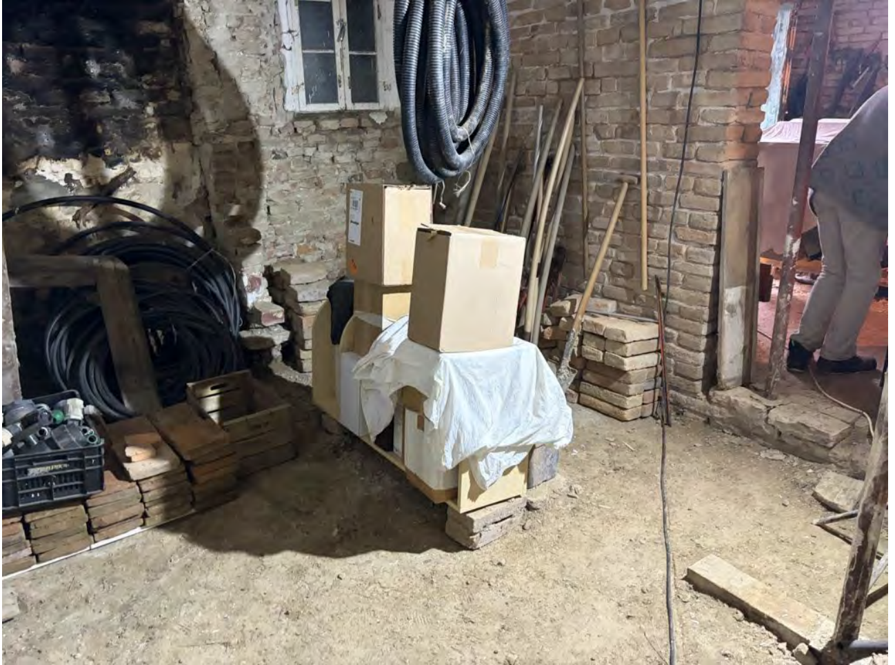
Foto 12. Interno abitazione piano terra
