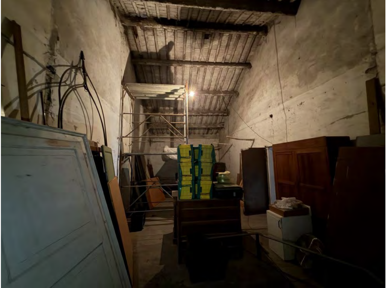
Foto 10. Interno abitazione piano primo
