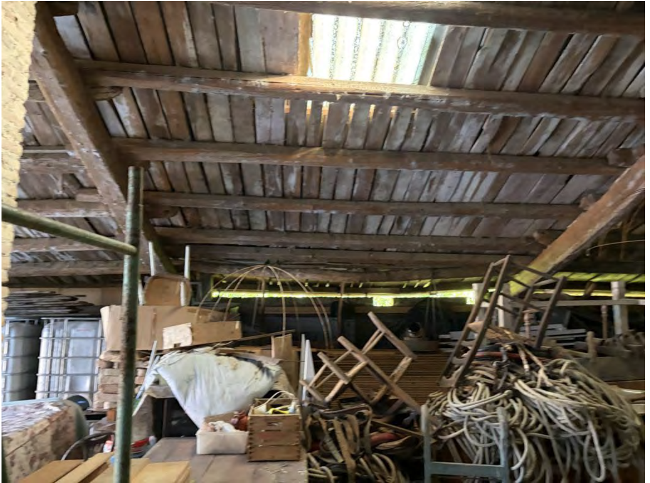
Foto 32. Particolare interno del fienile visto dal granaio
