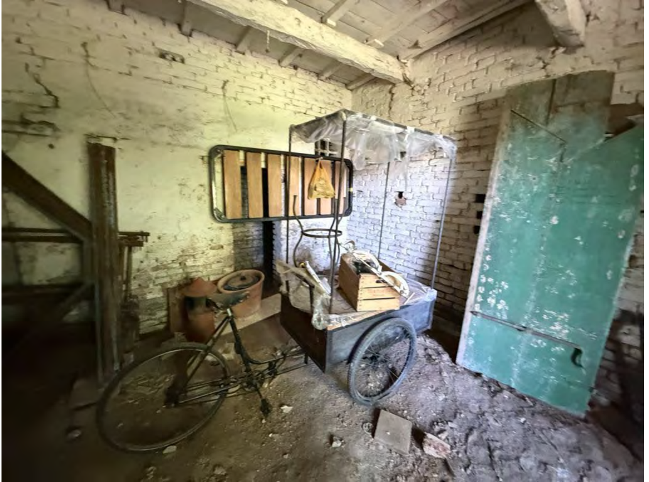
Foto 19. Vista dell'interno dell'abitazione. Magazzino al piano terra
