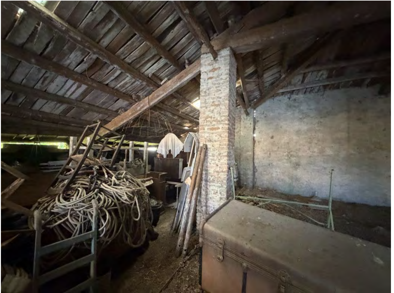
Foto 35. Particolare interno del fienile visto dal granaio
