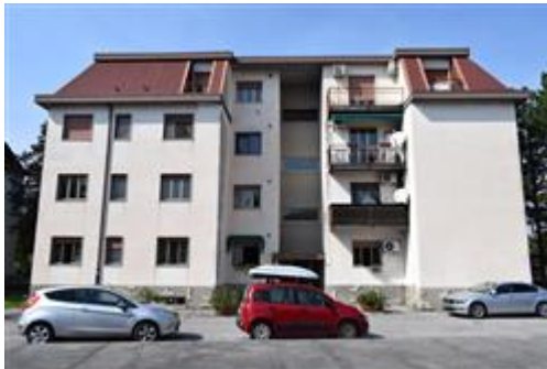
FACCIATA PRINCIPALE INGRESSO STABILE
