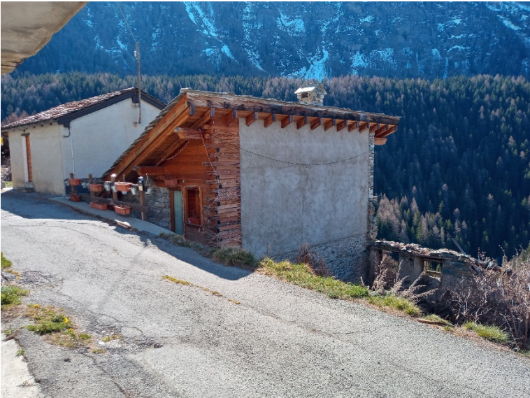
fronte nord ovest
