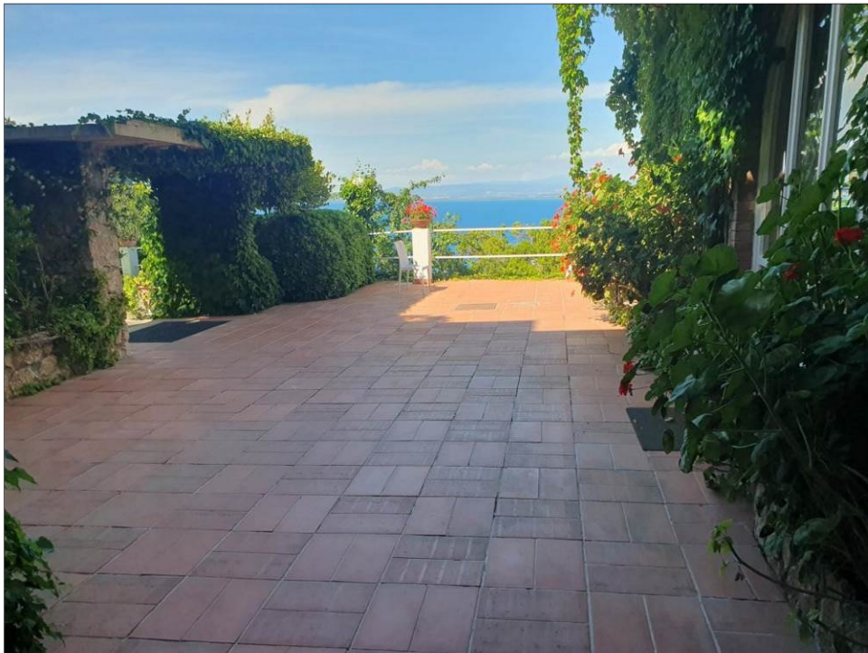
Foto 3 - Vista zona ingresso del fabbricato
