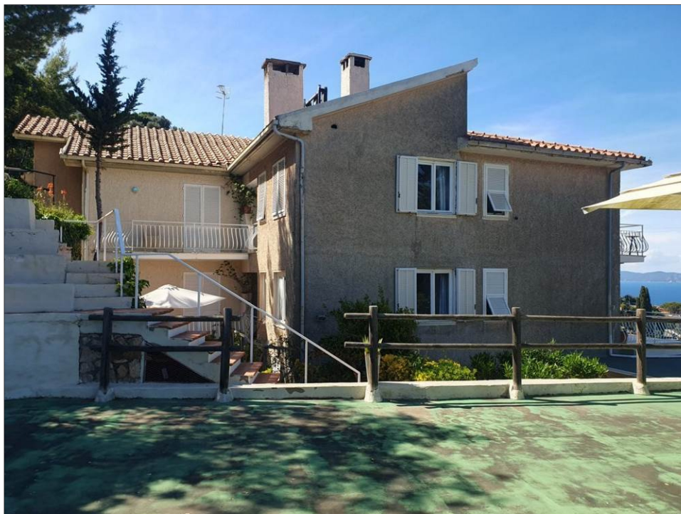
Foto 2 - Vista del retro del fabbricato
