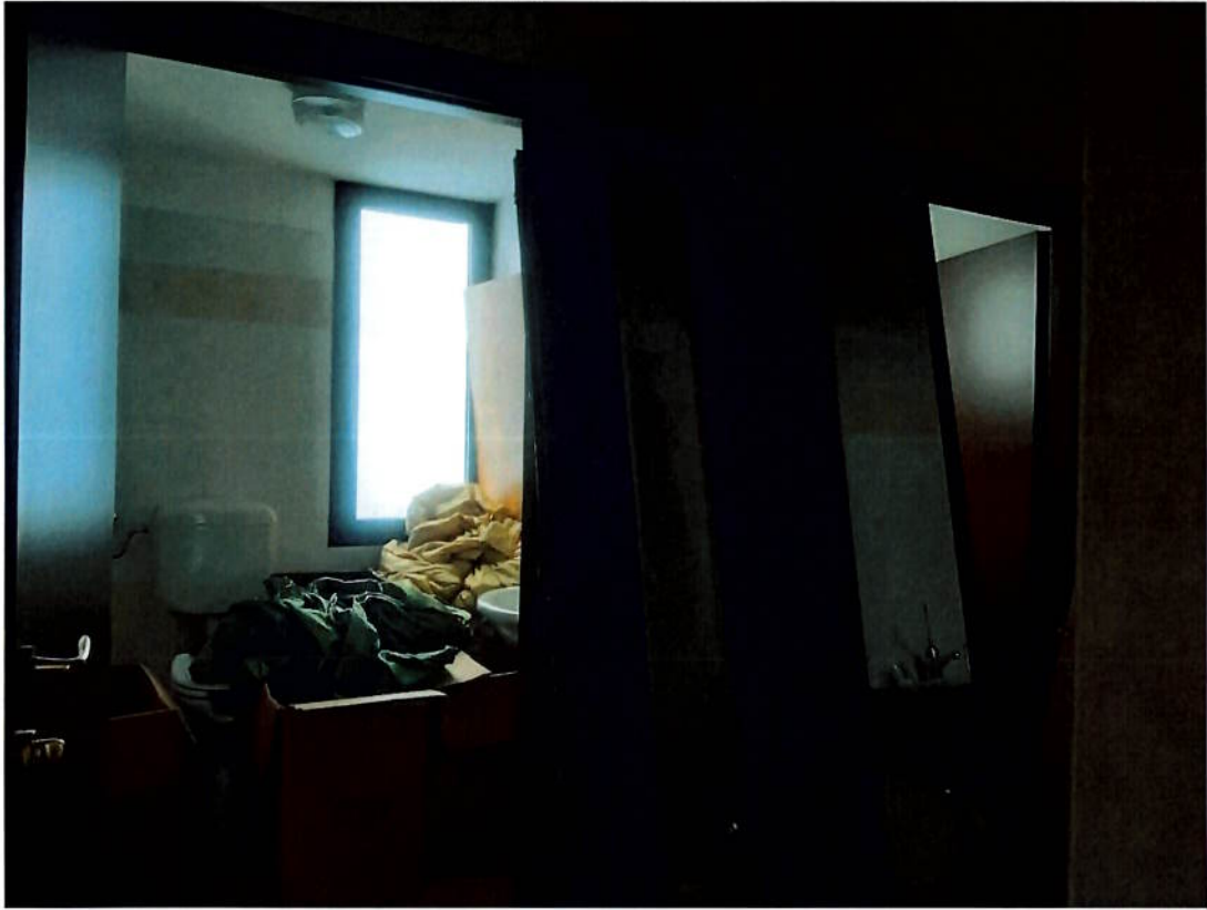
Foto n.13 – Bagni piano terra (sub 7)
