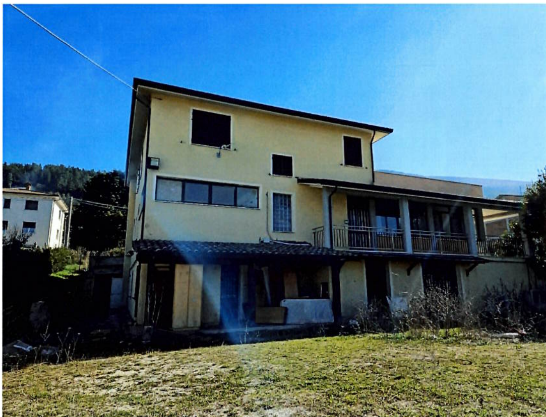
Foto n.3 – Esterni e corte (lato ovest)
