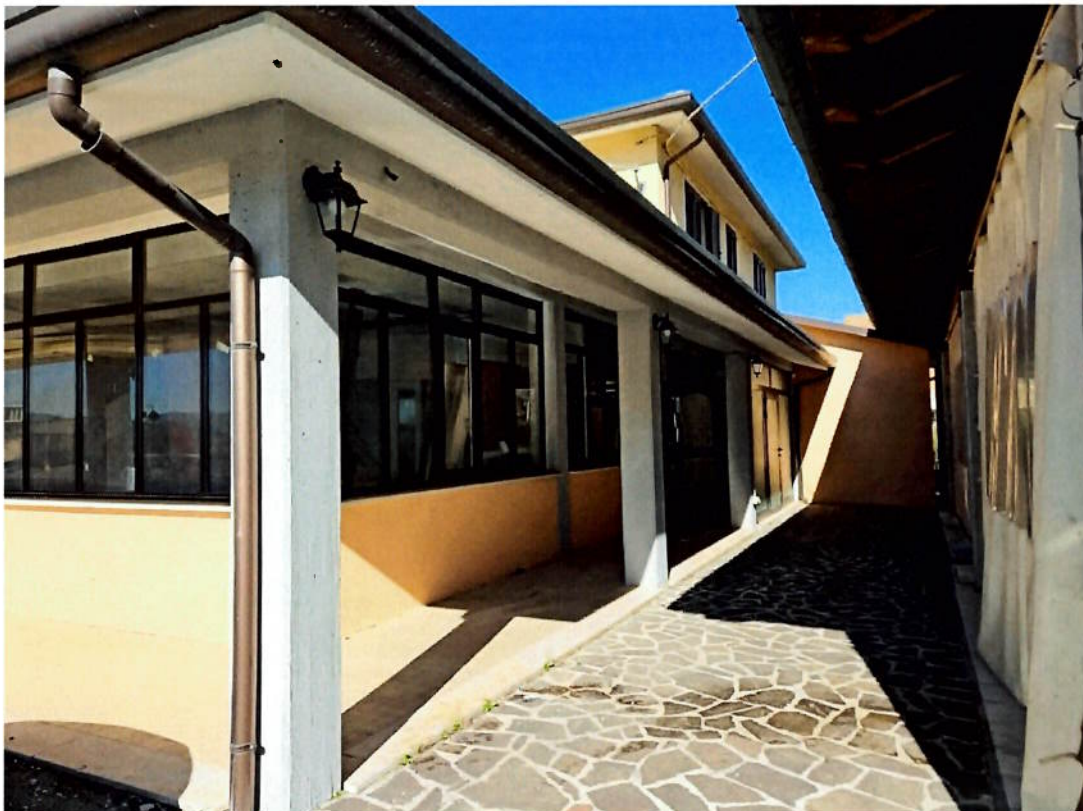
Foto n.4 – Esterno (lato est)
