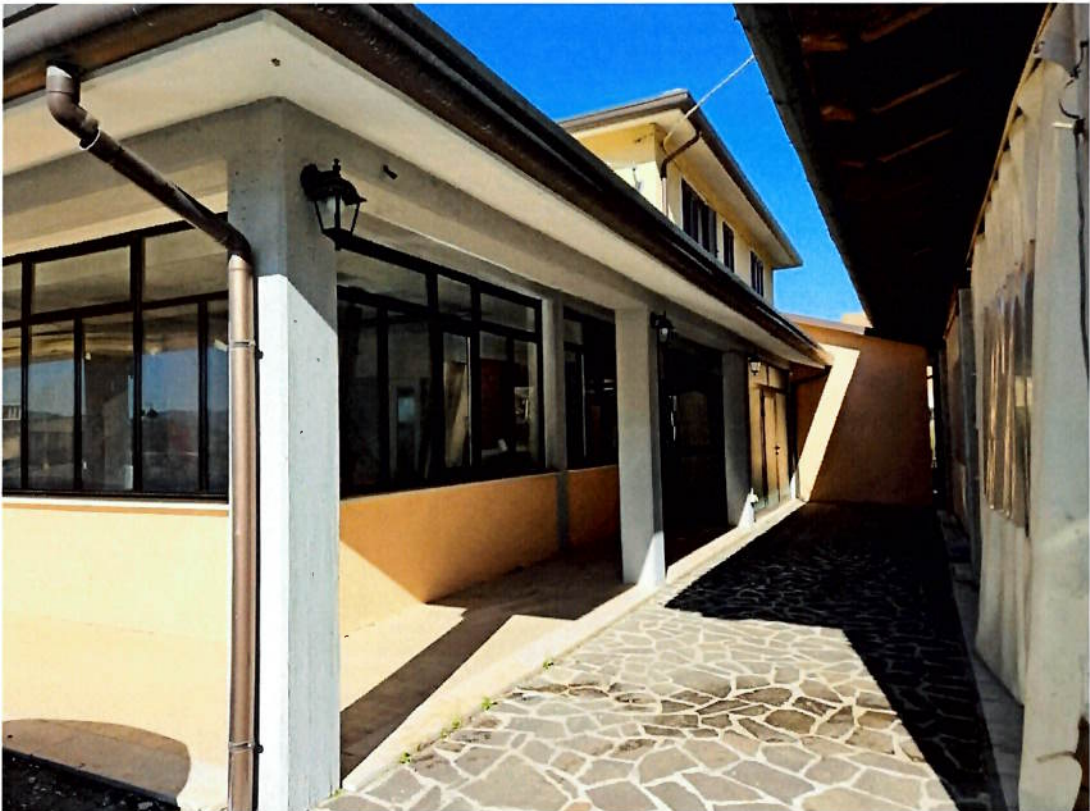
Foto n.4 – Esterno (lato est)
