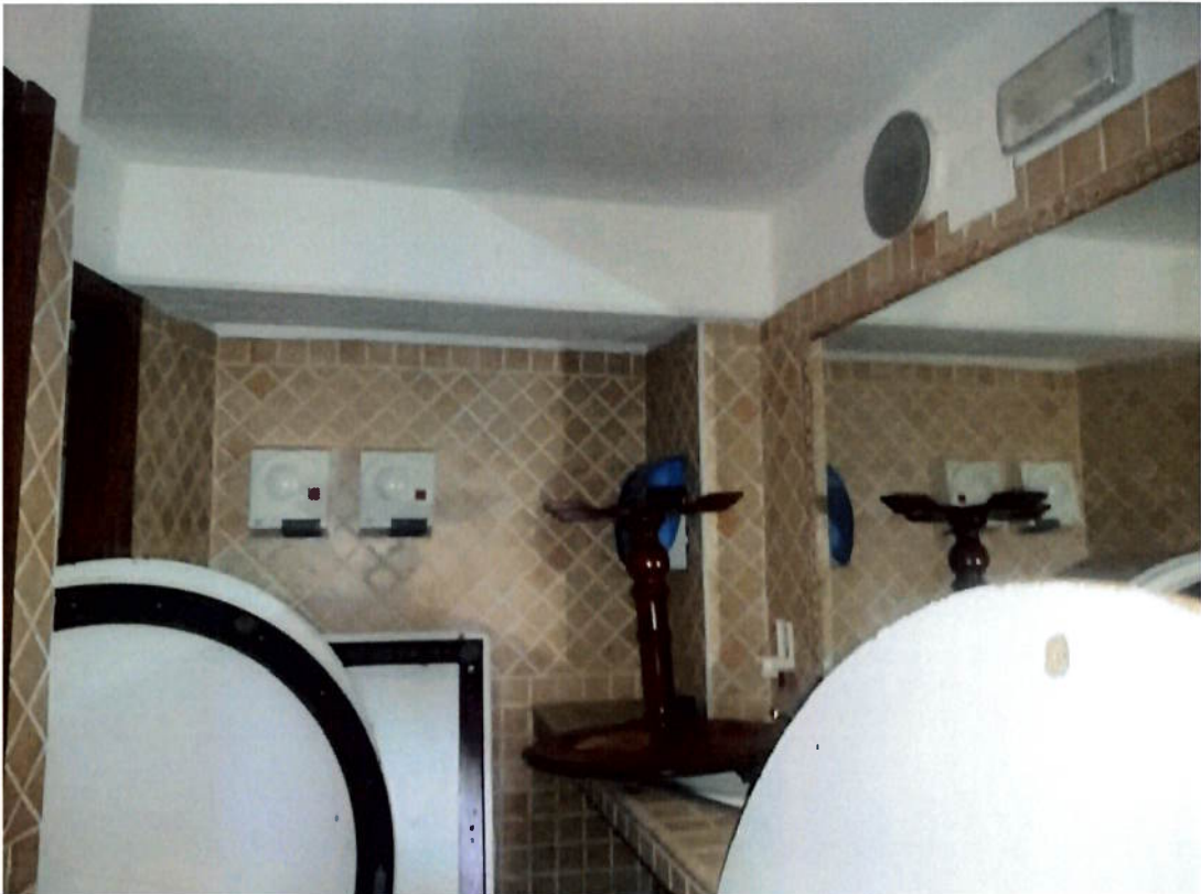
Foto n.8 – Bagni piano seminterrato (sub 7)
