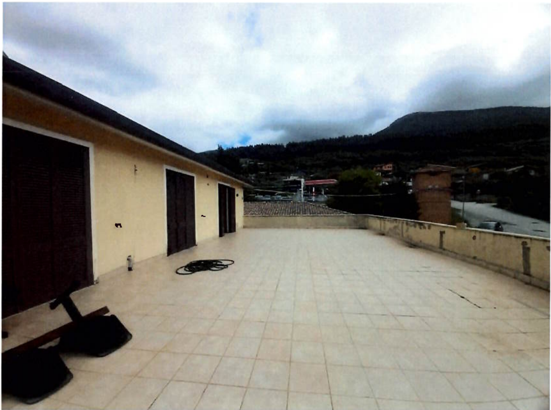
Foto n.16 – Terrazzo appartamento (sub 5)
