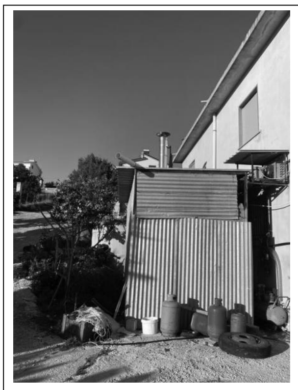
Fotografia n. 10 – Struttura precaria per impianti tecnologici
