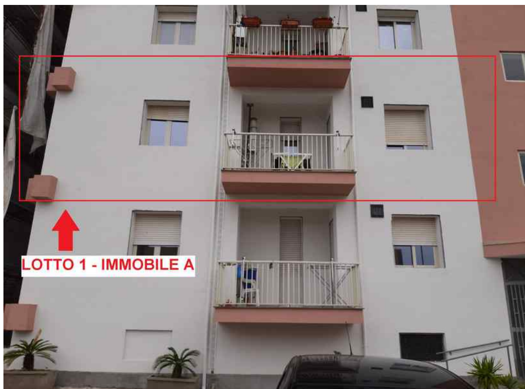
G.03 - Palazzina B – Individuazione del Lotto 1 - Immobile A al piano primo del prospetto frontale.
