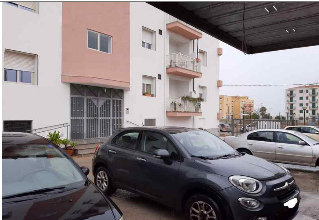
G.21 – Spazio esterno condominiale – sullo sfondo il cancello carrabile d'ingresso.
