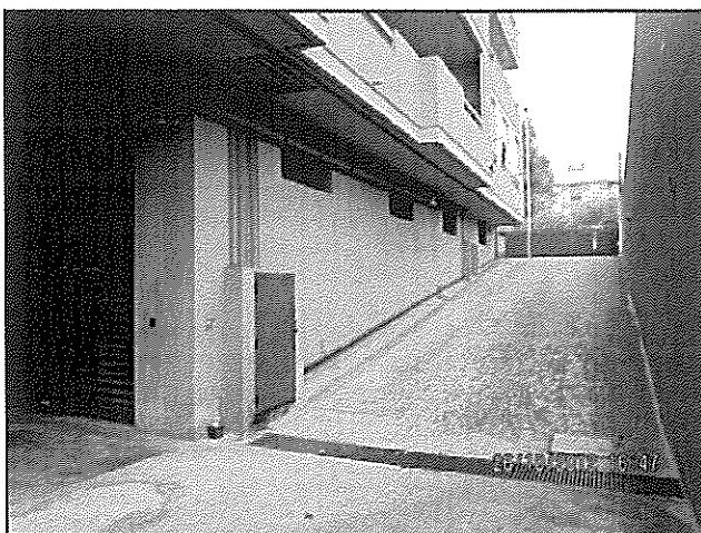
Foto n° 19: Rampa carrabile di accesso da via M. Angioni
