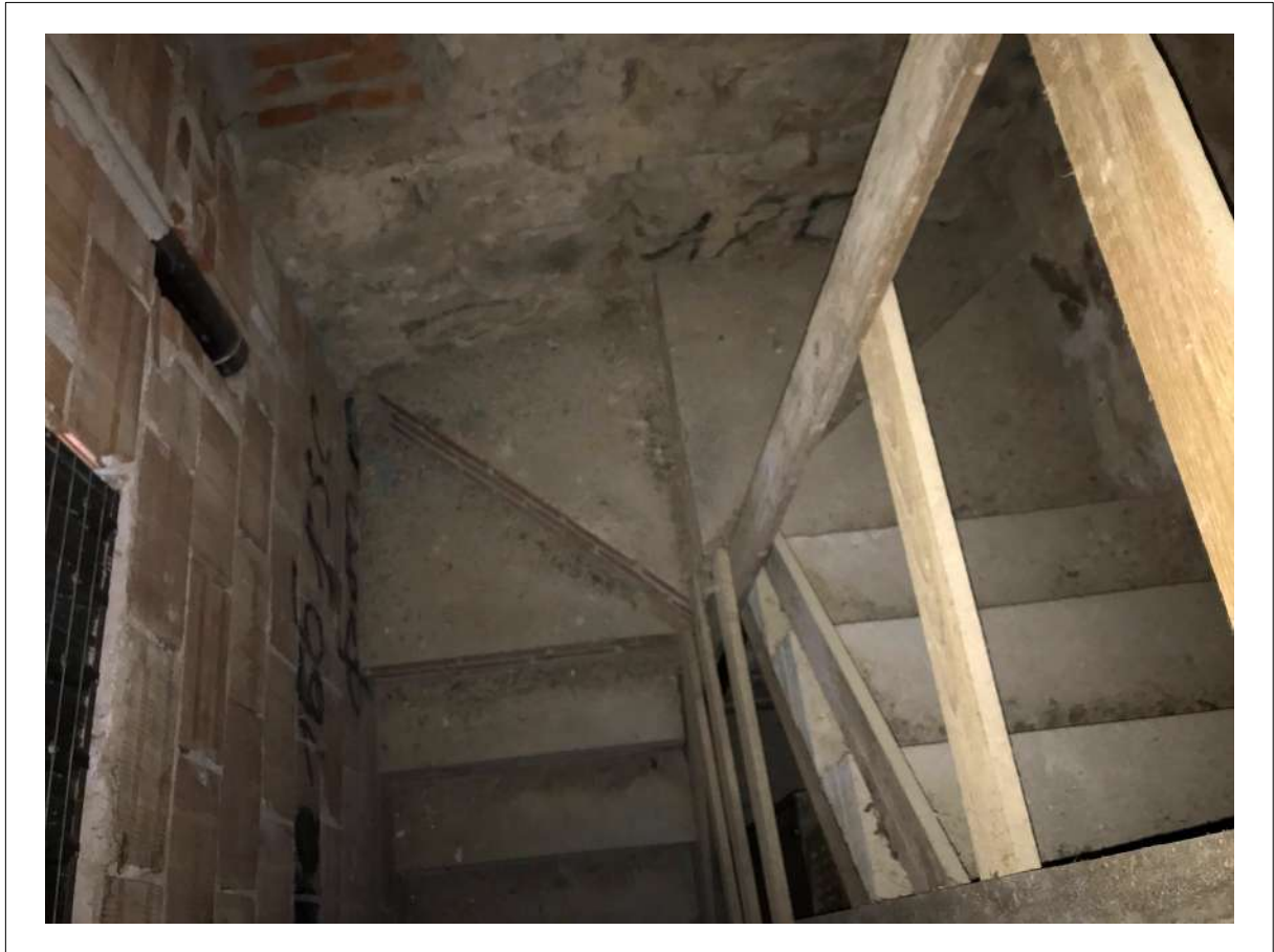
FOTO 27: Piano PRIMO - Vista del Vano Scala.
