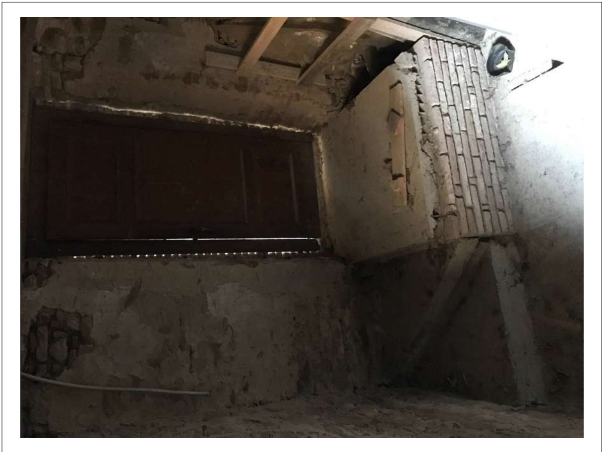
FOTO 13: Piano SEMINTERRATO - Vista interna della porta di accesso.
