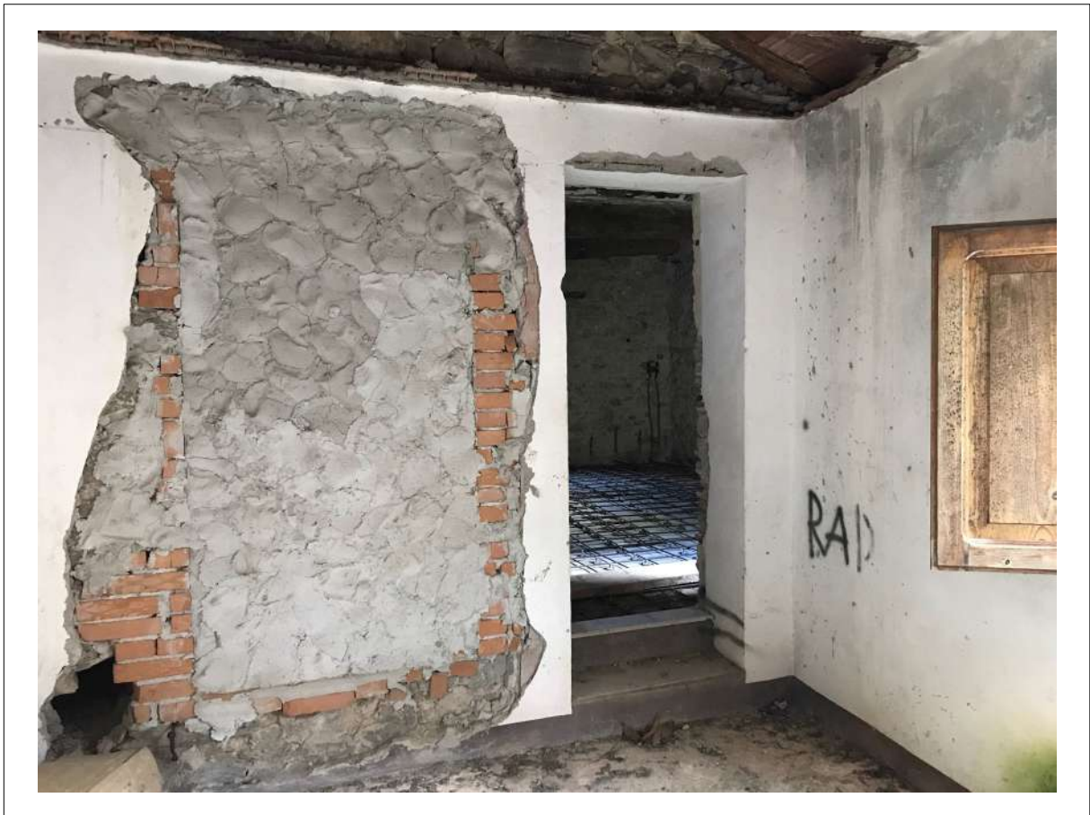
FOTO 34: Piano PRIMO - Vista dalla cameretta verso il vano principale.
