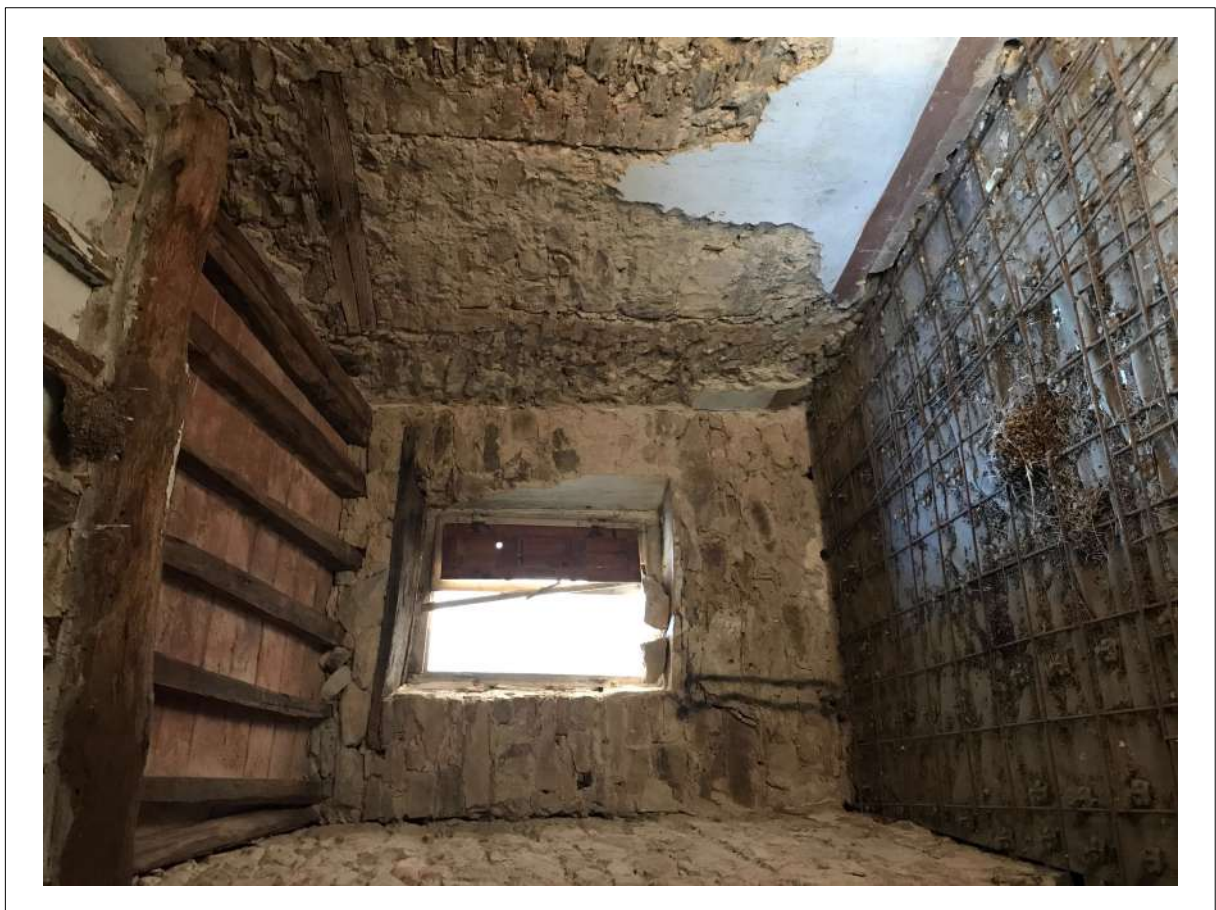
FOTO 28: Piano PRIMO - Vista del locale Armadi.
