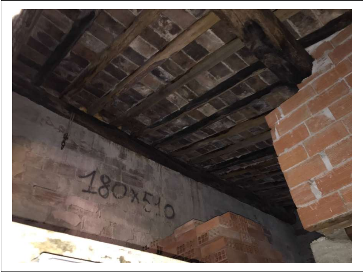
FOTO 37: Piano PRIMO - Vista verso la Soffitta (risultata inaccessibile).
