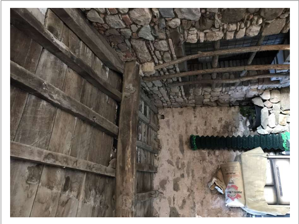
FOTO 11: Dettaglio del solaio soprastante il passaggio di cui alle foto precedenti. Ancora visibili le tracce lasciate dalla muratura perimetrale del volume non più esistente.
