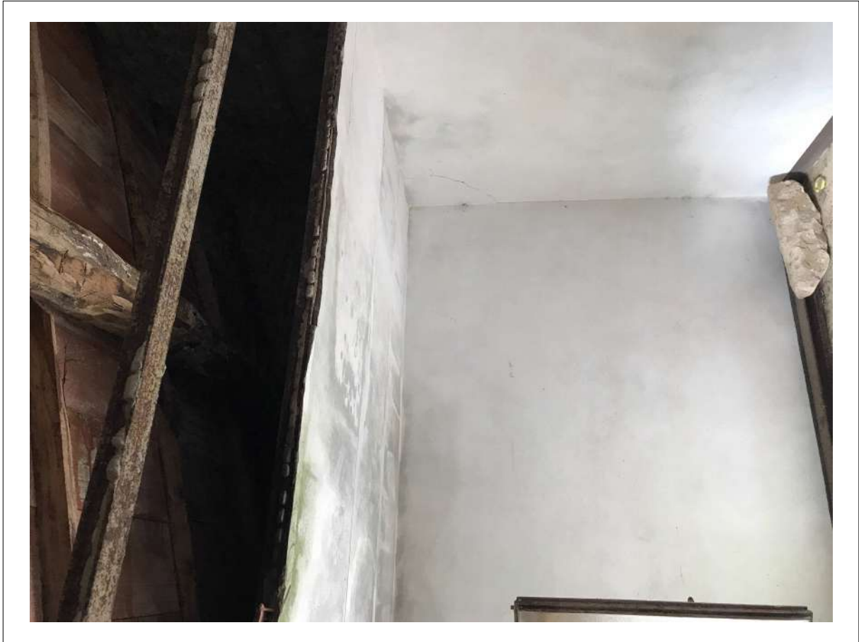
FOTO 33: Piano PRIMO - Vista della Cameretta - Controsoffitto parzialmente demolito e vista della copertura.
