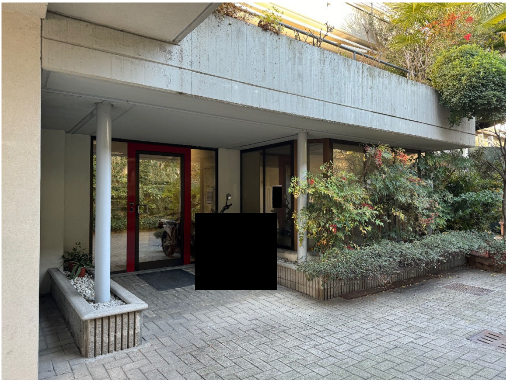
Corpo A - produttivo: ingresso laboratorio e uffici
