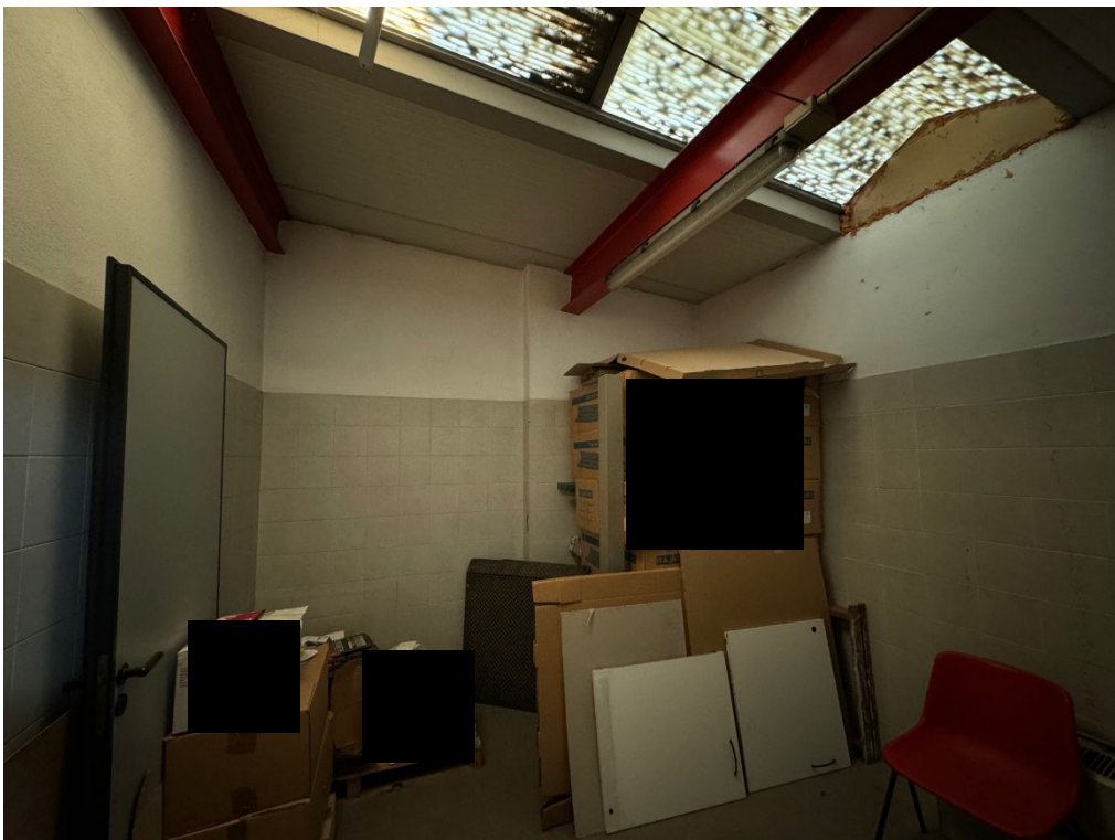
Corpo A - produttivo: spogliatoio
