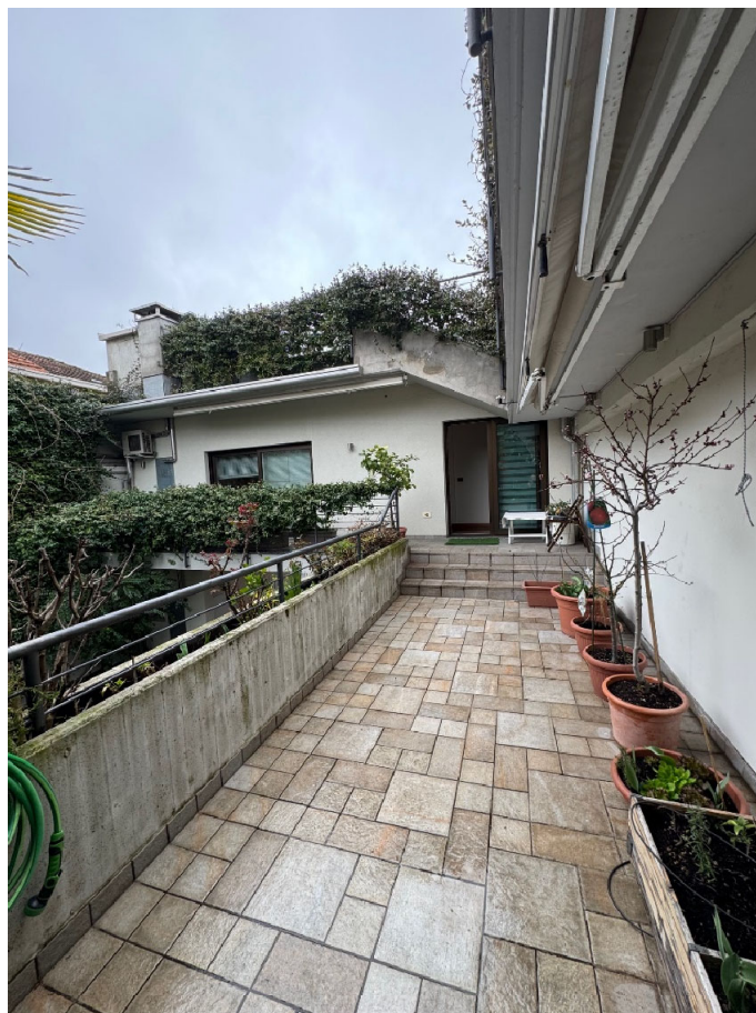
Corpo B - abitazione: balcone e terrazzo
