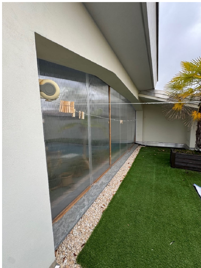
Corpo C - abitazione: terrazzo
