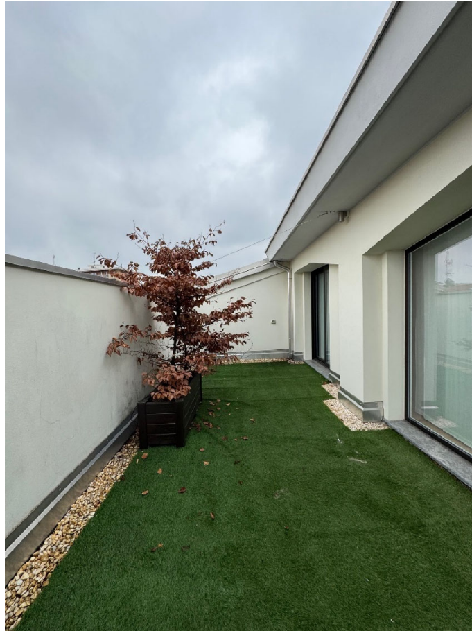
Corpo C - abitazione: terrazzo
