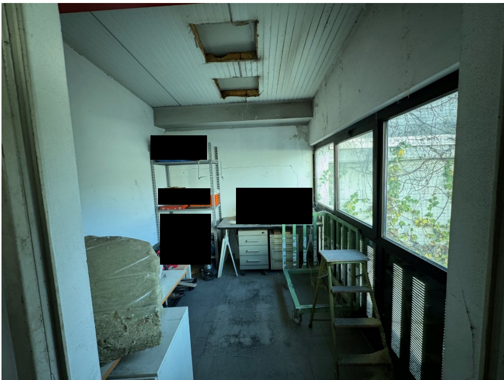
Corpo A - produttivo: deposito
