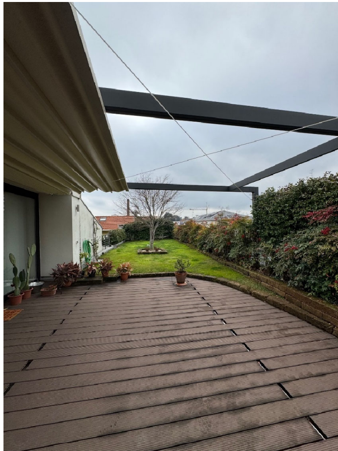
Corpo C - abitazione: giardino pensile
