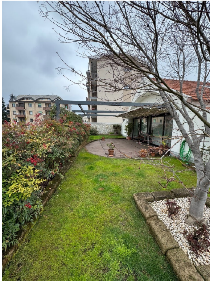
Corpo C - abitazione: giardino pensile
