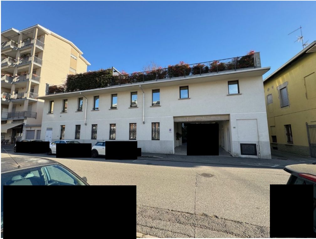
Vista da via Bellini
