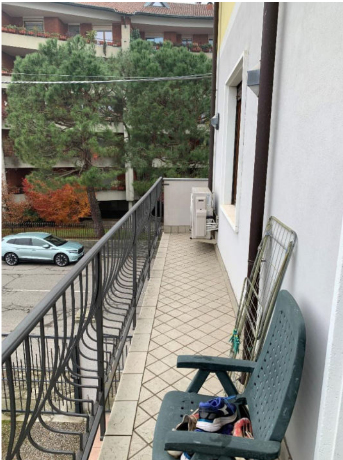
05 balcone lato cortile interno a piano primo
