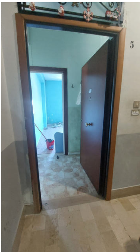
Foto n.9: Portoncino di ingresso
