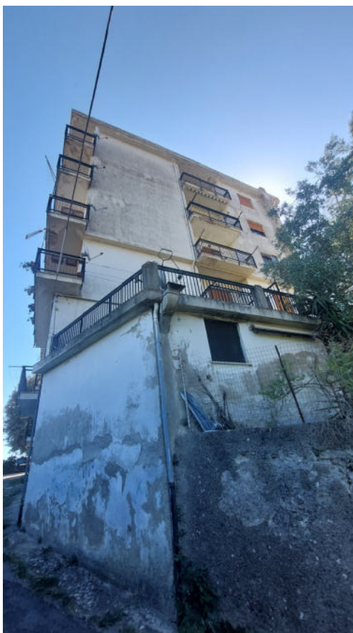
Foto n.4: Vista generale esterna – angolo nord-ovest
