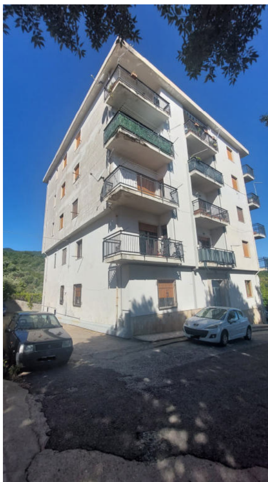
Foto n.2: Vista generale esterna – angolo sud-est
